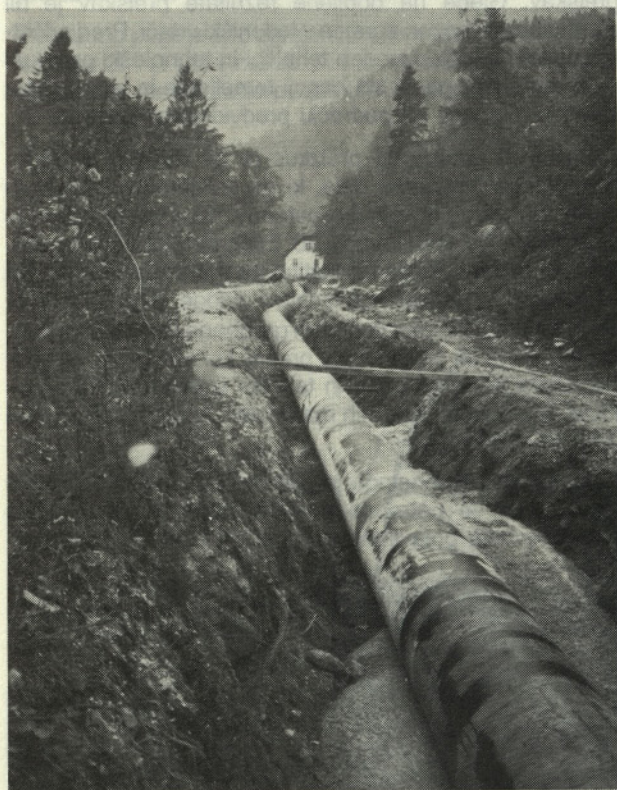
Slika 4. Tlačni cevovod pred tlačnim preizkusom
