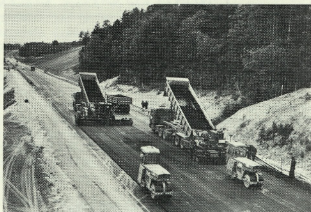
Izvajanje asfaltnih del na odseku Slovenike Celje-Dramlje
