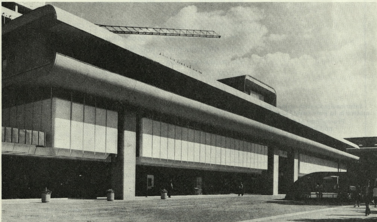
Slika 1. Pogled s Titove ceste
