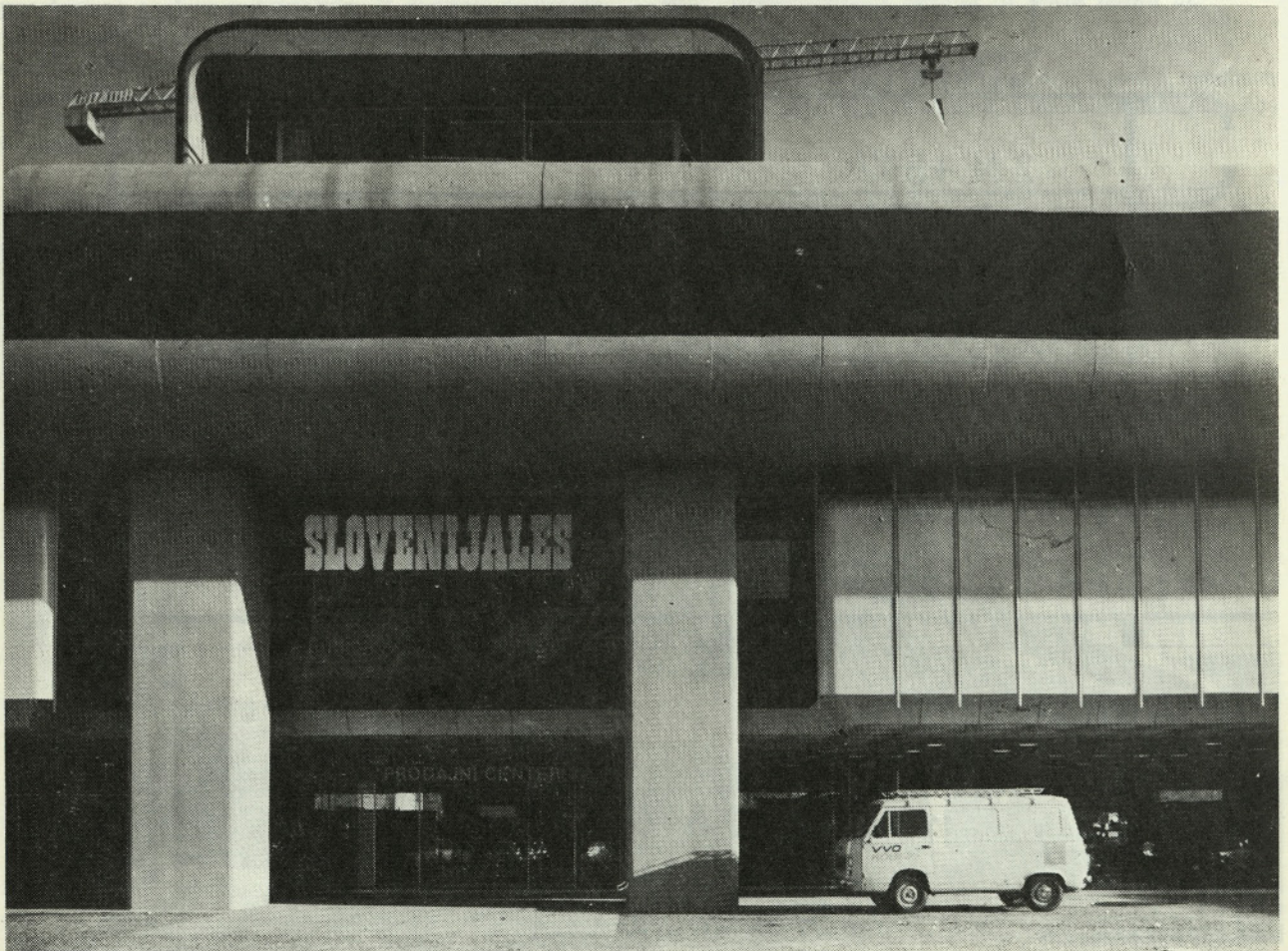
Slika 3. Pogled na srednji del
