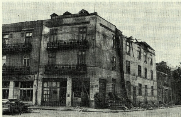
Slika 1. Skopje 1963: nosilni zidovi zgradbe niso bili teže poškodovani
