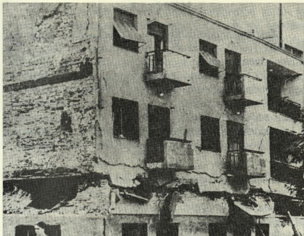
Slika 2. Skopje 1963: zgradba z nosilnimi zidovi le v prečni smeri se je porušila
