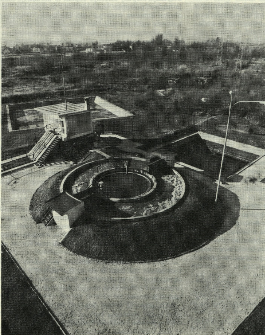
Sl. 1. Čistilna naprava za 4000 EPE v Crnučah pri Ljubljani. Projekt, izvedba in oprema Kanalizacija — Ljubljana
