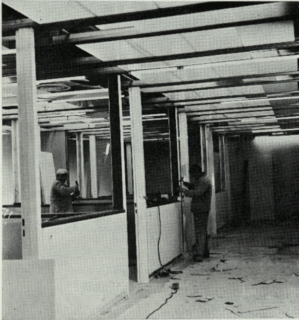
Izvajanje zaključnih del v DTS objektih
