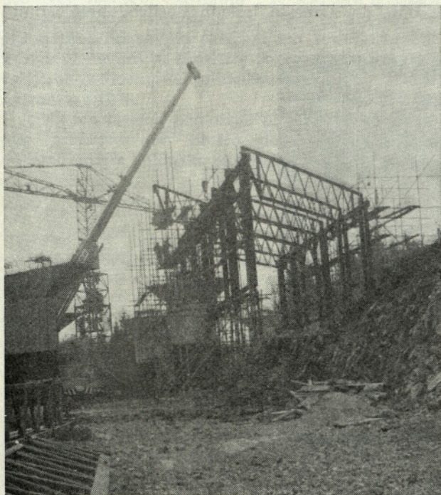
Sl. 4. Polaganje nosilcev za opaž čez progo
