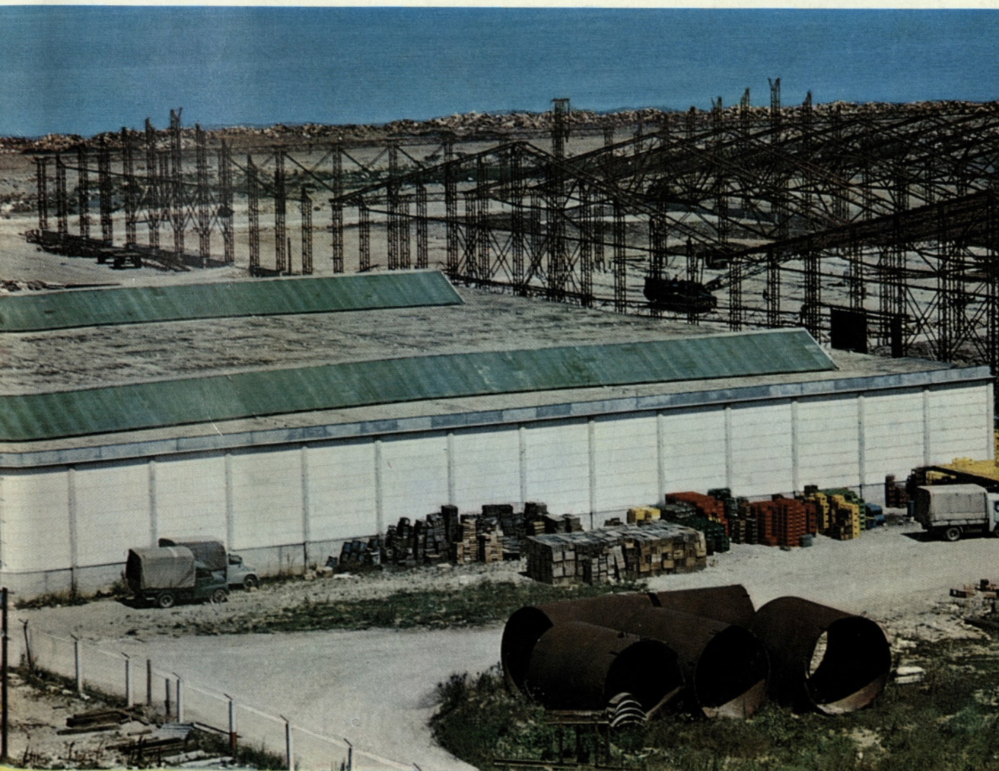
GIP GRADIS: Gradnja skladišč v luki Koper
