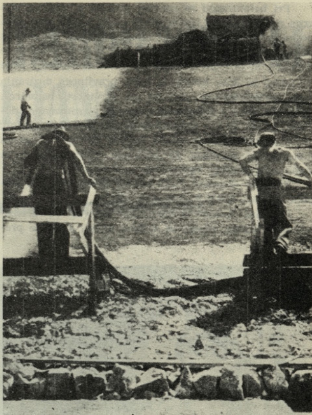
»Aliva 300« — betoniranje brežin akumulacije Birgl — Avstrija
