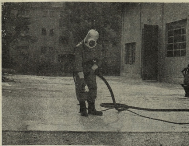
Aparatura za peskanje, torkret in brizgani beton
