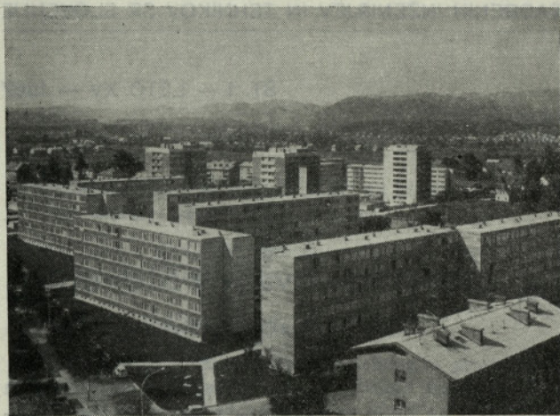
Montažna gradnja v Celju
