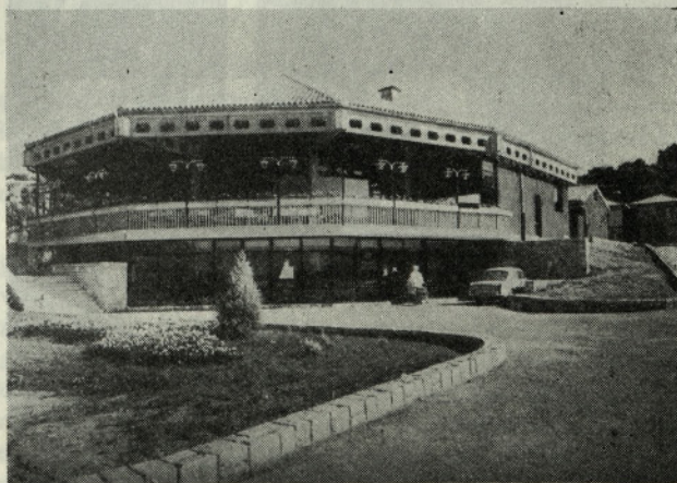
Restavracija Zusterna. Pogled s ceste
