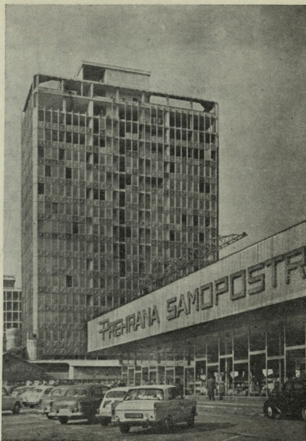
Trgovska poslovna stavba »Metalka«, viseča fasada je izdelana iz pofabriciranih armiranih elementov
