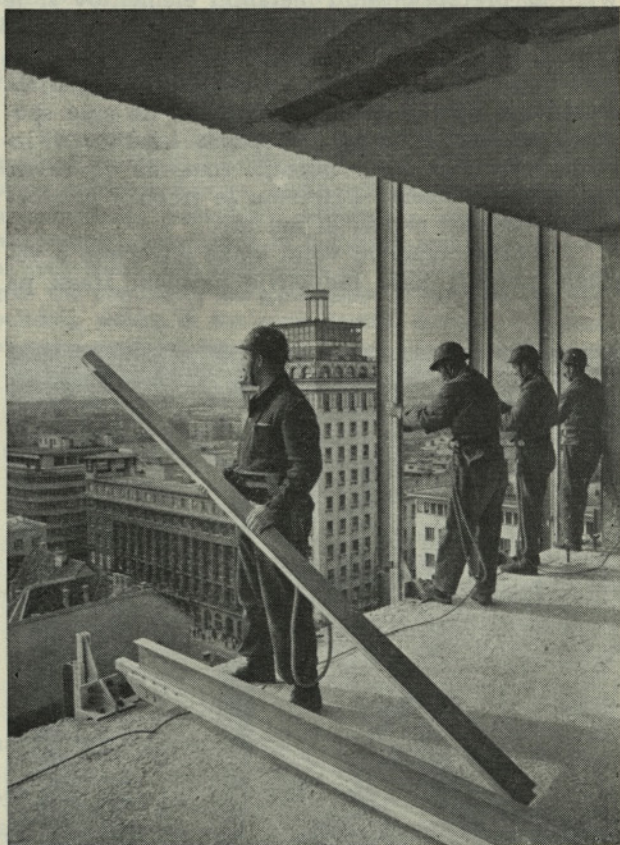
Posamezni elementi so izredno lahki. Monterji vstavljajo vertikalne profile, zavarovani so samo z gasilskimi pasovi (tudi varnostni odri so odpadli)
