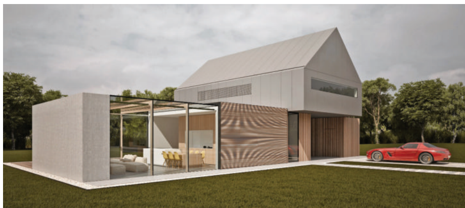
Slika 3 Pogled na izpostavljeni stekleni del hiše.
