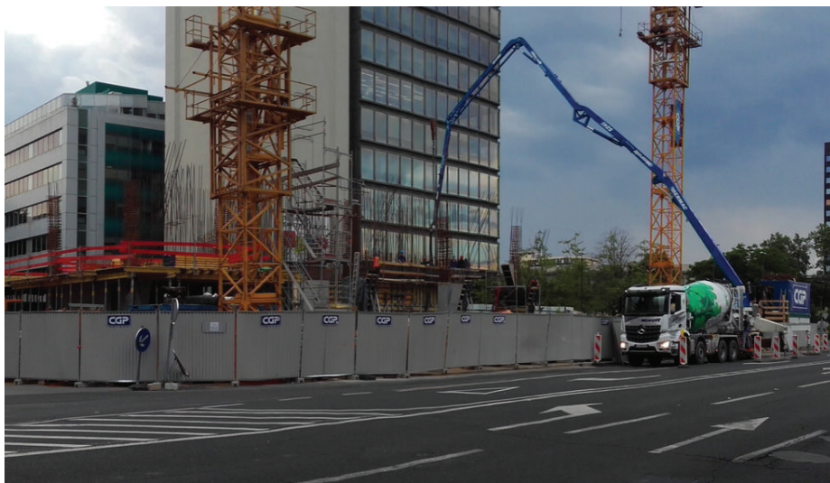
Slika 12: Betoniranje plošče nad pritličjem.
