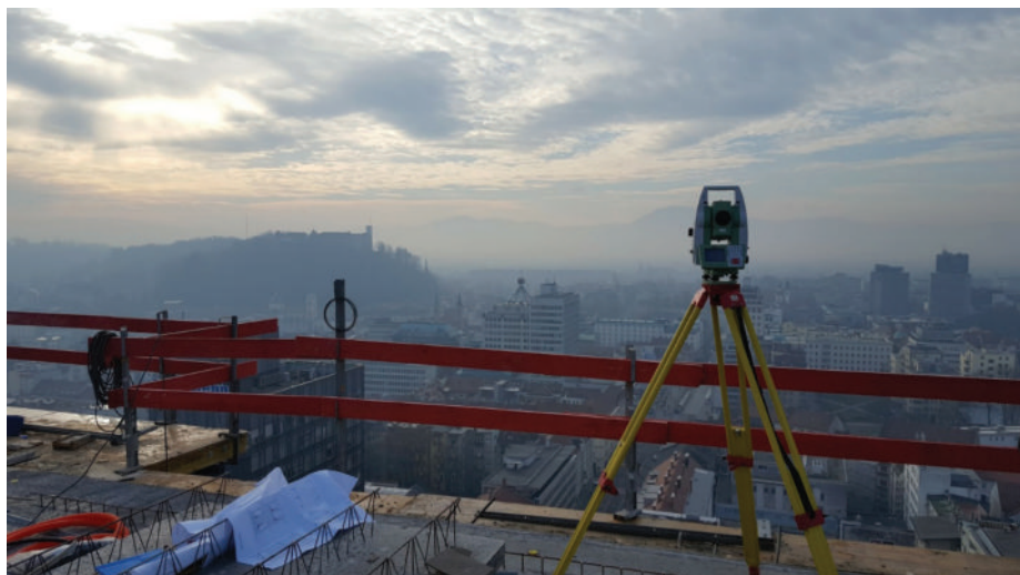
Slika 31: Geodetska spremljava gradnje.
