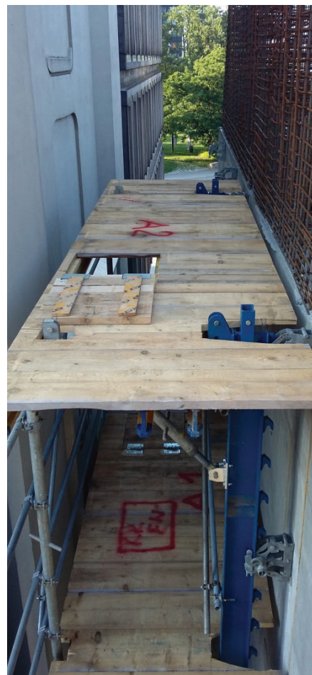
Slika 21: Plezajoči opaž Xclimb 60.
