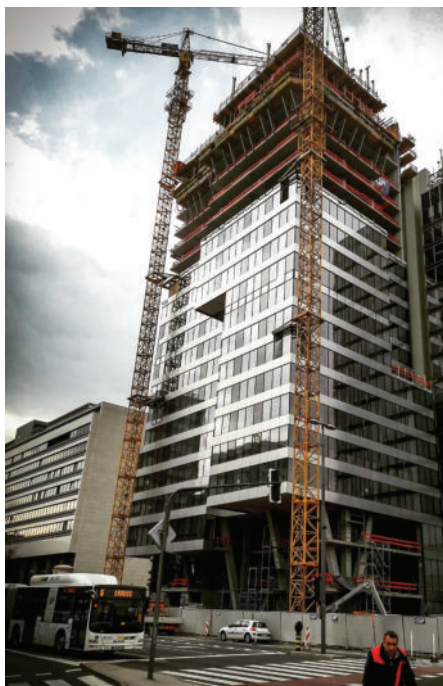
Slika 22: Gradnja zgornjih etaž in montaža fasade (spodaj).
