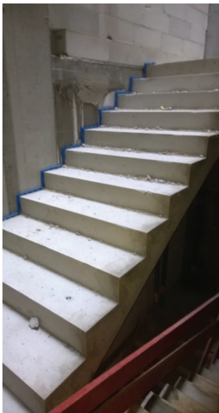
Slika 30: Vgrajene montažne armiranobetonske stopnice.
