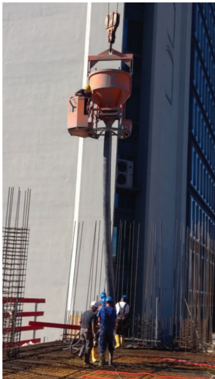
Slika 13: Betoniranje AB-plošče s pomočjo kible.
