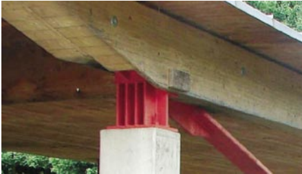
Slika 7 • Naleganje nosilca GL36c na jeklano podporo
