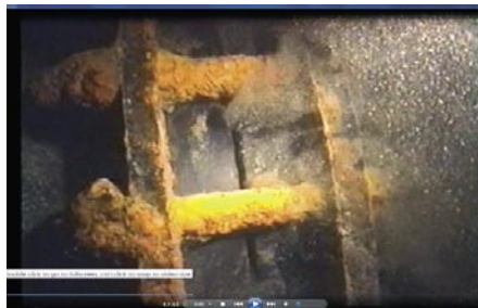
Slika 5 • Stik na cevi je za dotok vode namerno razprt
