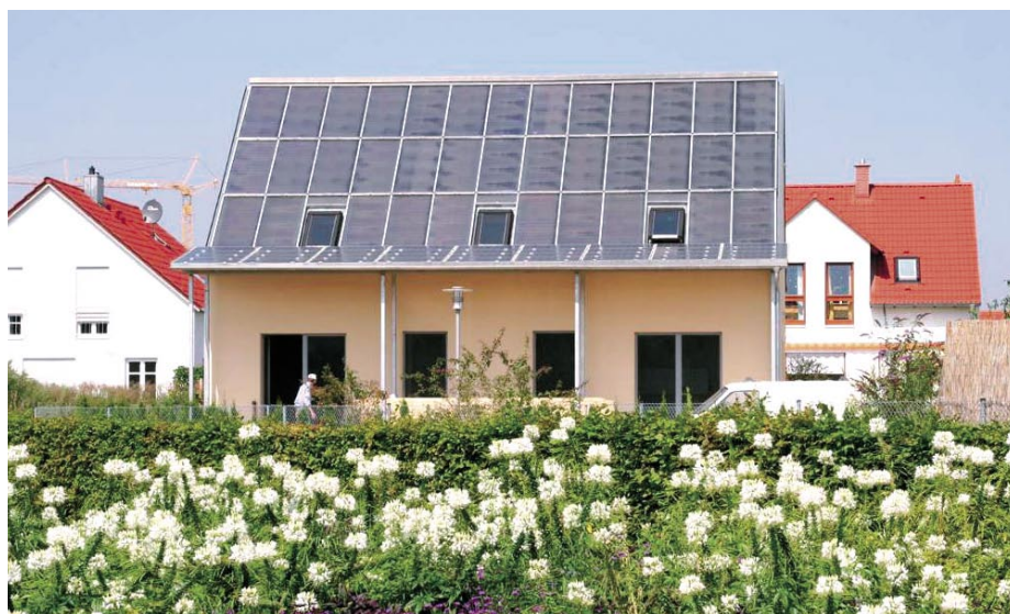
Slika 5c • Sončna hiša v kraju Regensburg, ki je 100-odstotno solarno ogrevana nizkoenergijska hiša, zgrajena z opeko Schlagmann T8 in 83 m 2 sončnih kolektorjev
