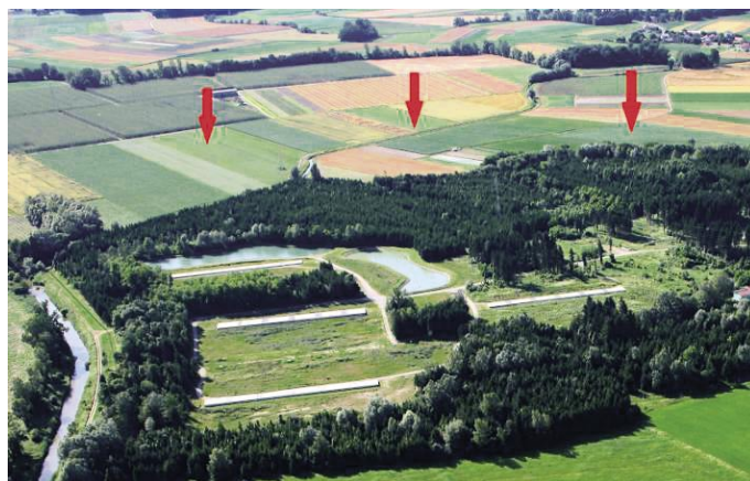
Slika 2 • Varovano območje črpališča skupinskega vodovoda Ormož za štiri občine z 19.000 prebivalci. Na sliki sta vidna dva varnostna rezervoarja s štirimi pokritimi bazeni za bogatenje podtalnice
