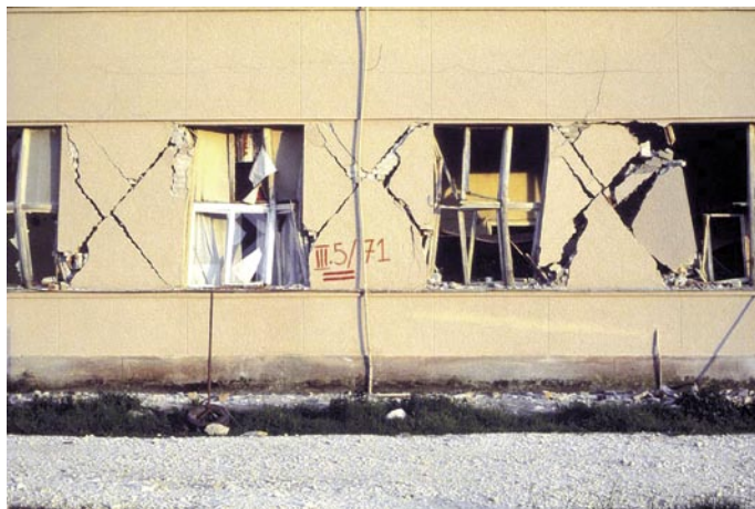
Slika 2 • Strižna porušitev opečnih slopov med potresom
