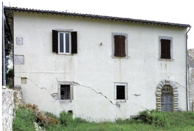
Slika 3 • Strižne razpoke v stari kamniti hiši po potresu
