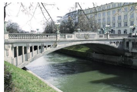
Slika 6 • Zmajski most iz leta 1901 ima tričlenski armiranobetonski lok, zgrajen po sistemu Melan (foto: G. Humar)
