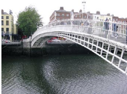
Slika 8 • Litoželezni most Liffey na istoimenski reki v Dublinu iz leta 1810 (ECCE, 2009)
