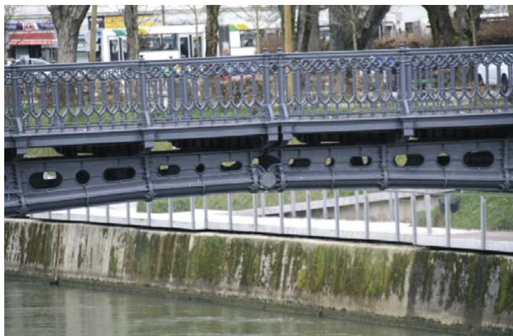
Slika 17 • Hradeckega most – srednji štiri ločni segmenti imajo nad cevjo samo vzdolžno rebro, medtem ko imajo preostali ločni segmenti diagonale in vertikale. (foto: G. Humar)
