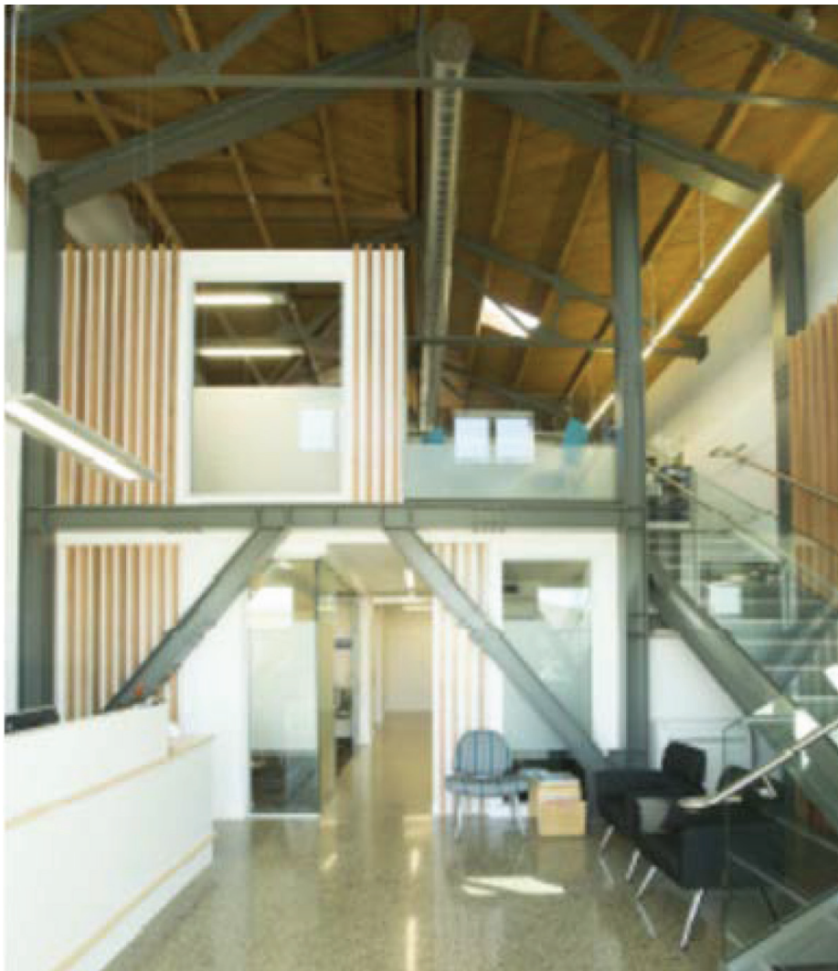
Slika 23 • Z vidnim jeklenim okvirjem utrjena stavba.
