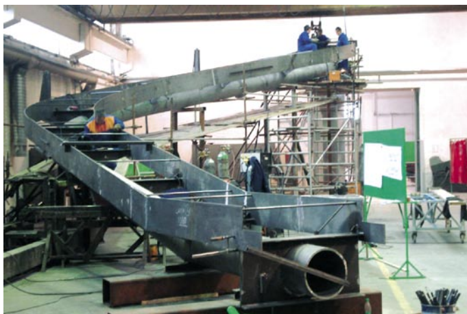
Slika 11 • Poskusno nameščanje mostu v delavnici
