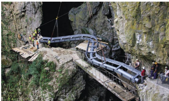
Slika 13 • Nameščanje glavne nosilne konstrukcije
