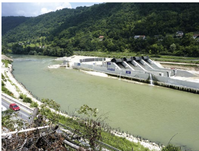
Slika 6 • Zaključena dela v I. gradbeni jami HE Krško; zgrajena so 4 prelivna polja in križna zidova na levem bregu Save; stanje na 3. julij 2009
