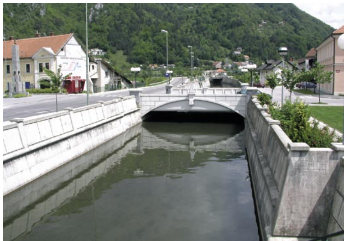
Slika 2 • Brežine regulirane Sopot v Radečah
