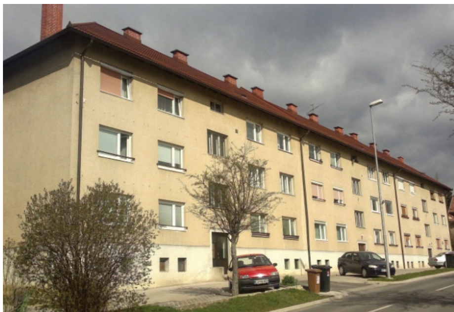
Slika 2 • Večstanovanjska stavba A.
