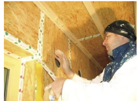
Slika 8 • Kakovostna montaža in natančno polepljeni stiki so ključni za zagotavljanje zrakotesnosti objekta
