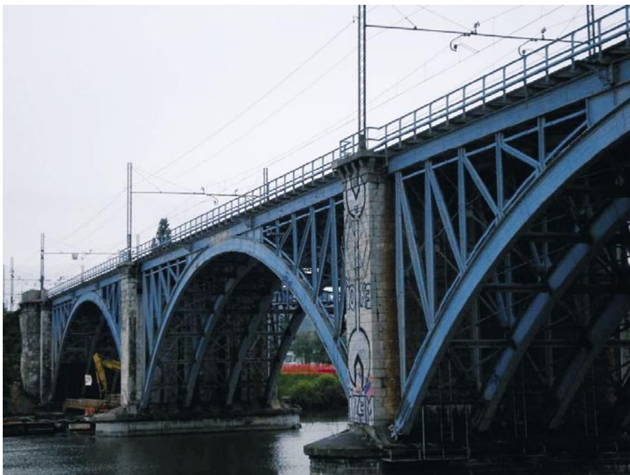
Slika 4 • Železniški most nosi tri tire
