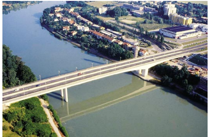
Slika 14 • Pogled iz zraka na Koroški most
