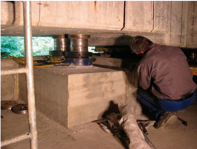
Slika 5 • Dvig konstrukcije z dvigalkami (levo), odviti sidrni vijak M24 (desno).
