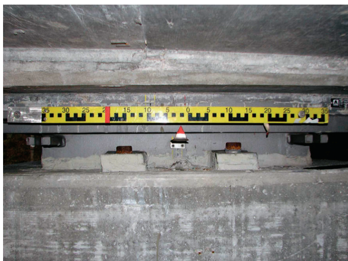
Slika 2 • Stanje lončnega obstoječega ležišča v osi 6 ((ZAG, 2008), (CPM, 2010)).
