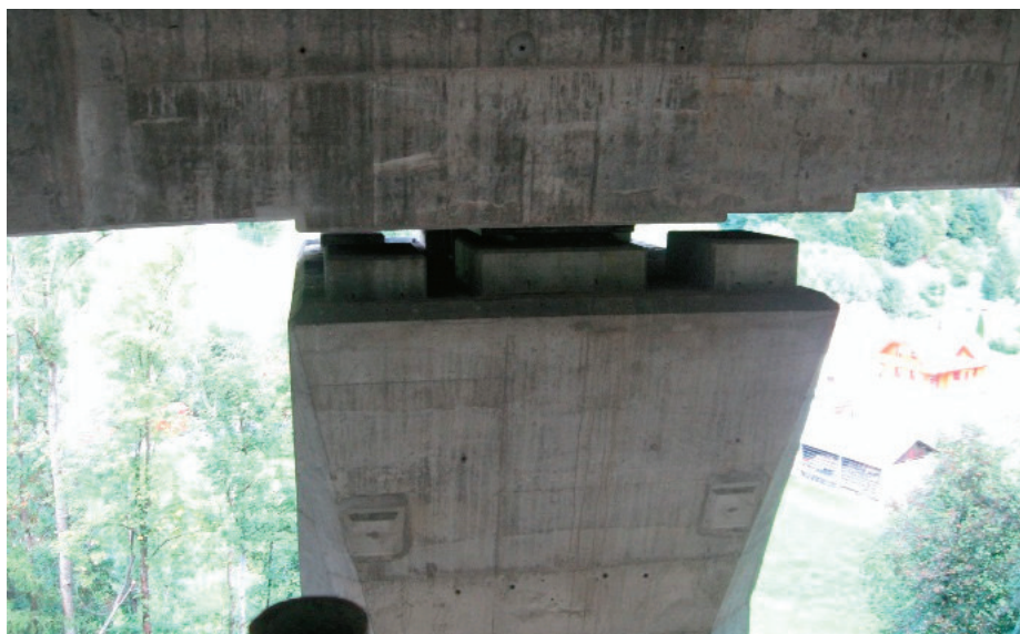
Slika 10 • Pogled na nova ležišča v osi 6 viadukta Petelinjek.
