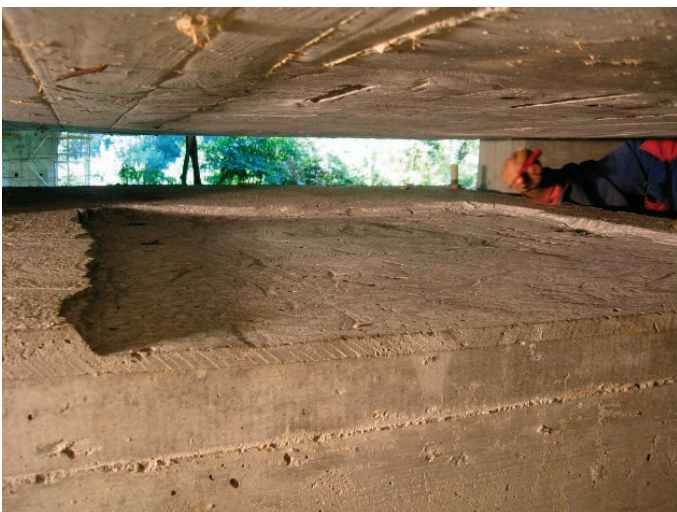
Slika 7 • Obdelana spodnja površina ležišča (levo), priprava opaža zgoraj (desno).
