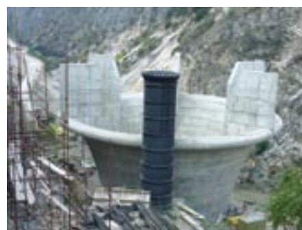
Slika 6 • Ustje visokovodnega preliva z ozračevalno cevjo
