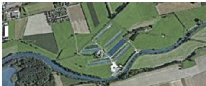
Slika 17 • Bogatenje podtalnice z vodo Ruhra pri kraju Westick pod čistilnimi napravami odpadne vode
