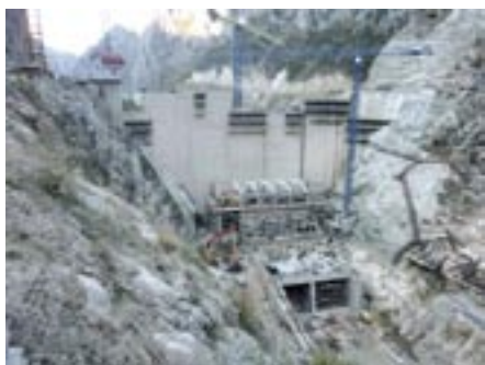
Slika 2 • Gradbišče pregrade Sveta Petka
