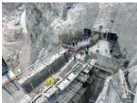
Slika 4 • Nadomestitev slabše hribine z betonskim blokom
