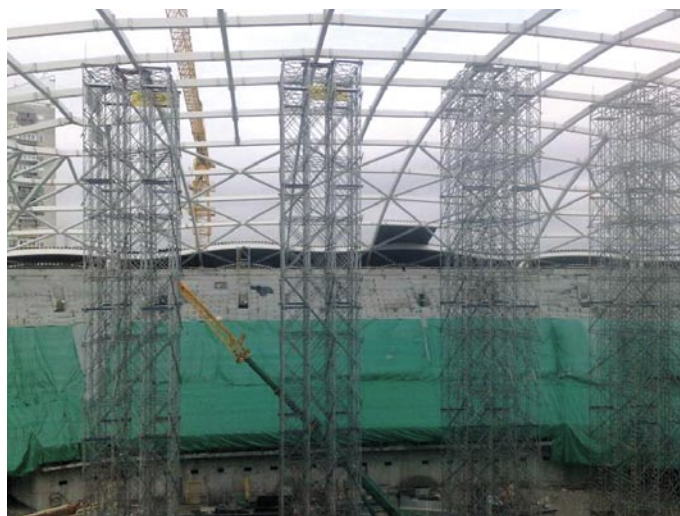
Slika 10 • Izdelava posameznih elementov v delavnici, sestava na gradbišču na tleh in montaža jeklene konstrukcije strehe
