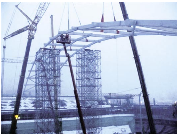
Slika 10 • Izdelava posameznih elementov v delavnici, sestava na gradbišču na tleh in montaža jeklene konstrukcije strehe
