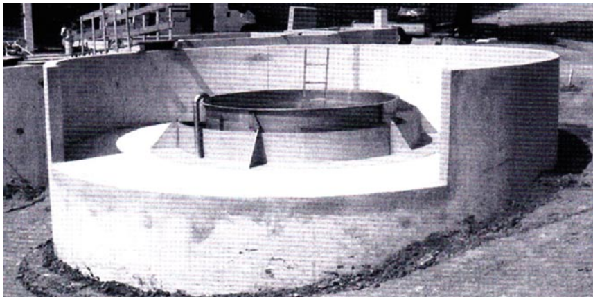
Slika 3 • Armiranobetonski vrtnični separator
