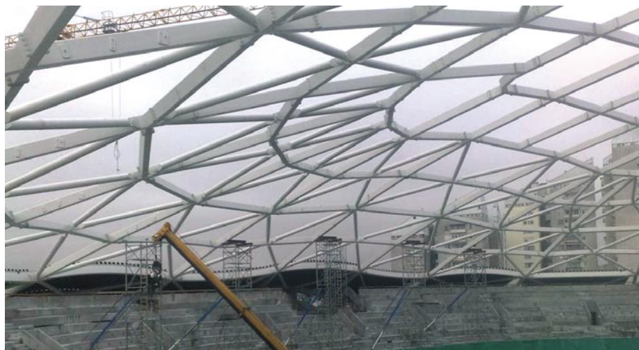
Slika 7 • Jeklena konstrukcija strehe med montažo
