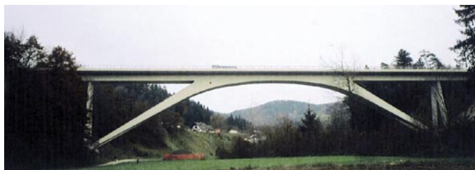
Slika 9 • Viadukt na radeljski obvoznici
