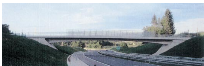
Slika 13 • Nadvoz na avtocestnem odseku Lešnica–Kronovo
