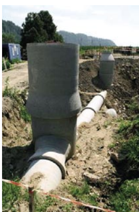
Slika 10 • Gradnja kanalizacije (foto: Ljubo Motore)
