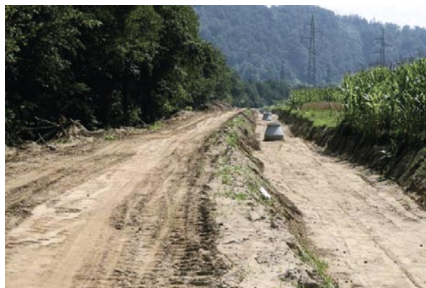
Slika 9 • Gradnja kanalizacije (foto: Ljubo Motore)
