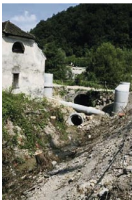
Slika 8 • Gradnja kanalizacije (foto: Ljubo Motore)
