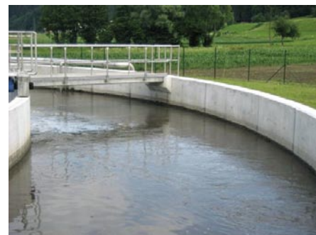
Slika 13 • Prezračevalni bazen (foto: Uroš Krajnc)
