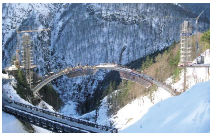
Slika 10 • Viadukt Mangart v gradnji
