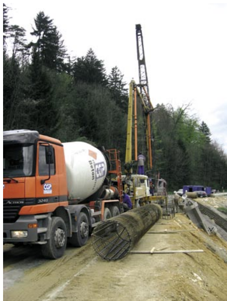
Slika 3 • Betoniranje pilotov pilotne stene PZ-1
