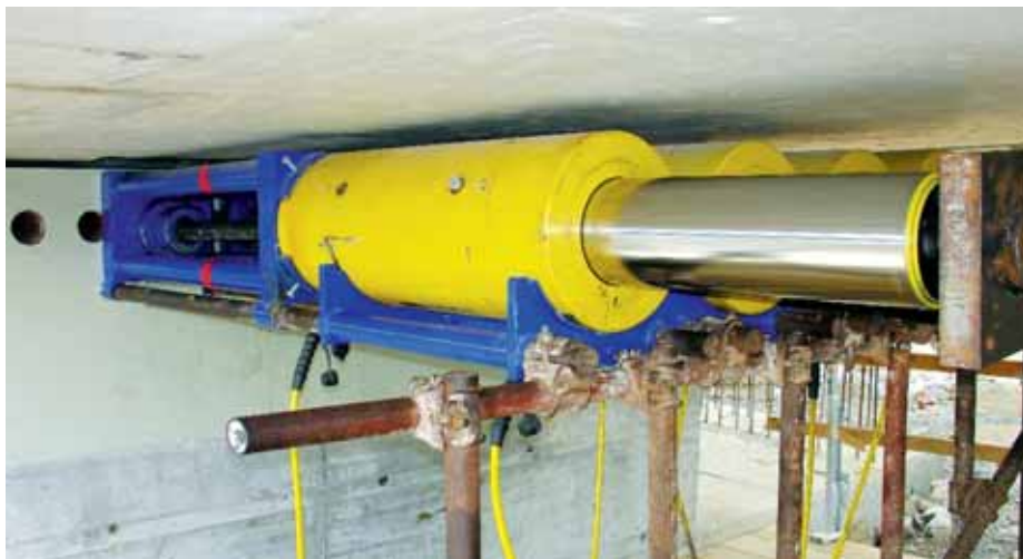
Slika 2 • Sistem vlečenja in zadrževanja s palicami Dywidag
