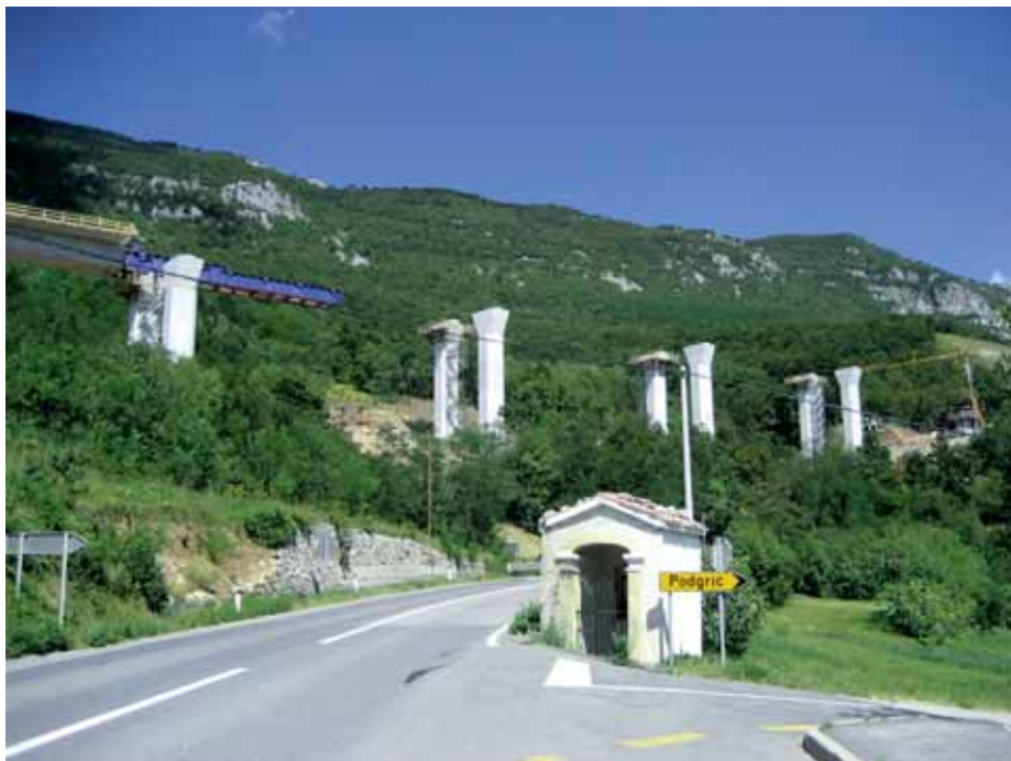
Slika 3 • Pogled na juhovzhodni del viadukta Polance z magistralne ceste Podnanos–Razdrto
