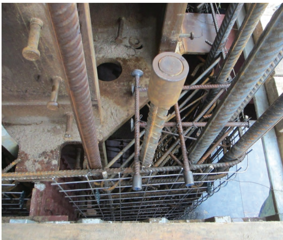
Slika 44 • Armatura stebra in sidra v vogalu stebra.
