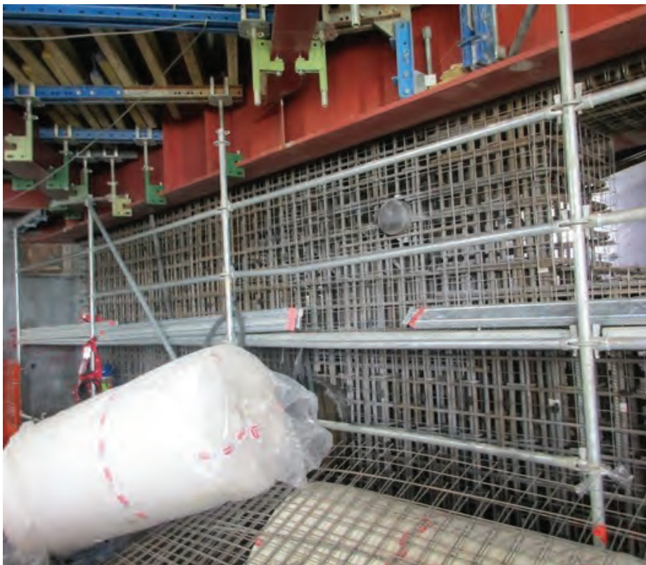
Slika 34 • Armatura stene prečnika v 33. etaži.
