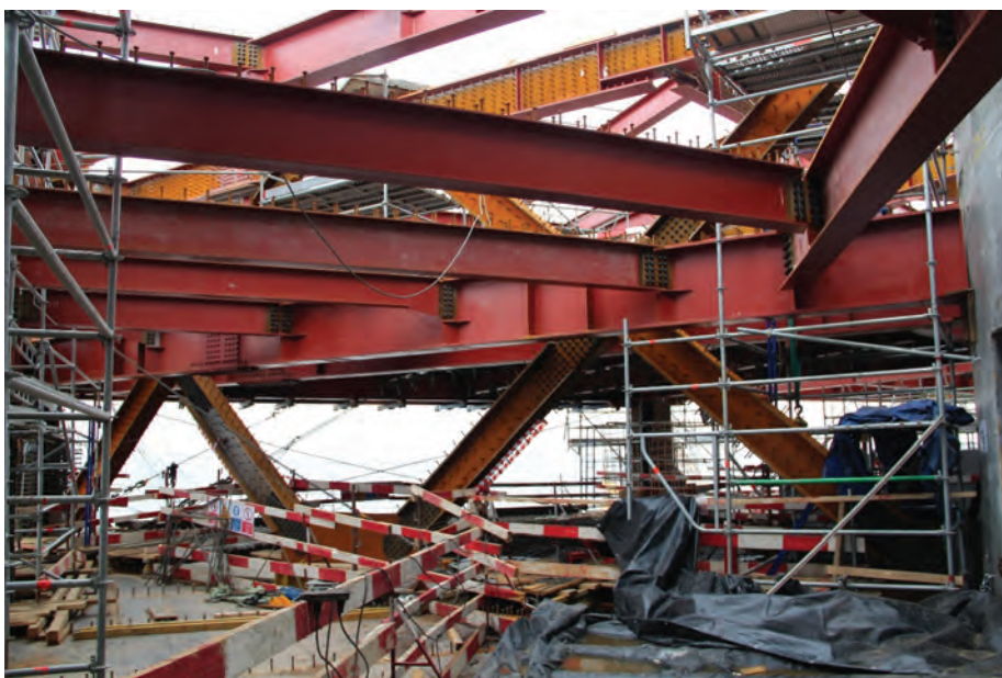
Slika 32 • Jekleno paličje prečnika v 33. in 34. etaži.
