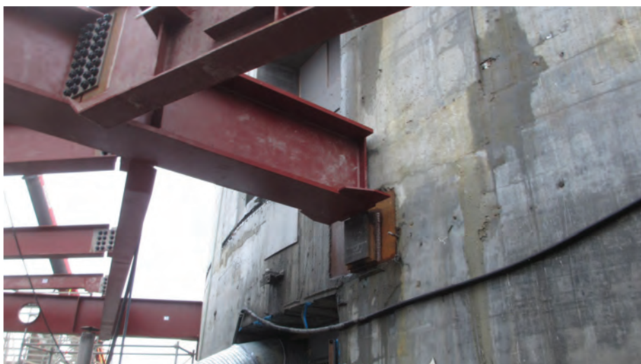
Slika 46 • Stik nosilca stropa s steno jedra.
