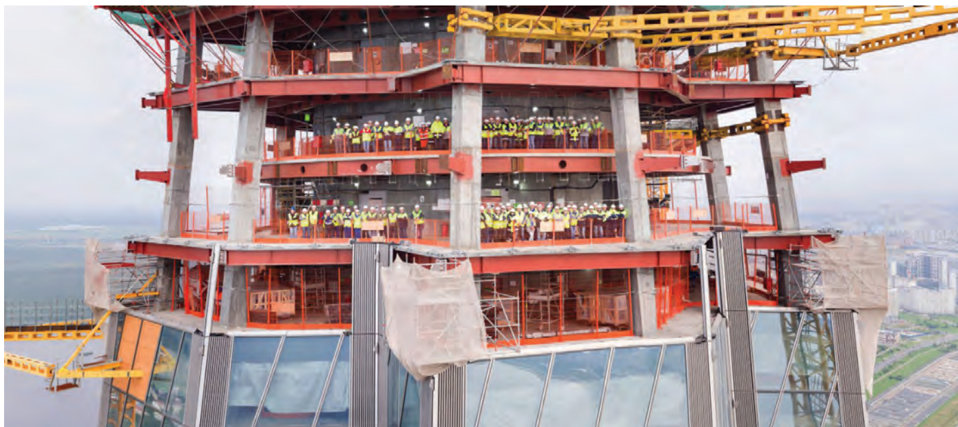
Slika 6 • Udeleženci projekta na gradbišču Lakhta Center.
