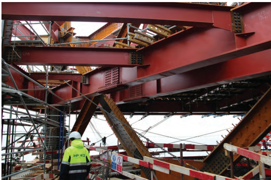
Slika 60 • Postavitev jeklenih konstrukcij etažnih plošč.
