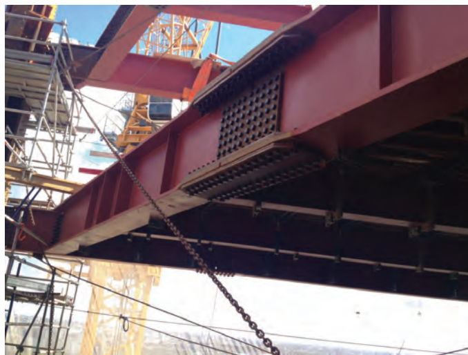
Slika 50 • Vijačeni stik nosilca plošče.
