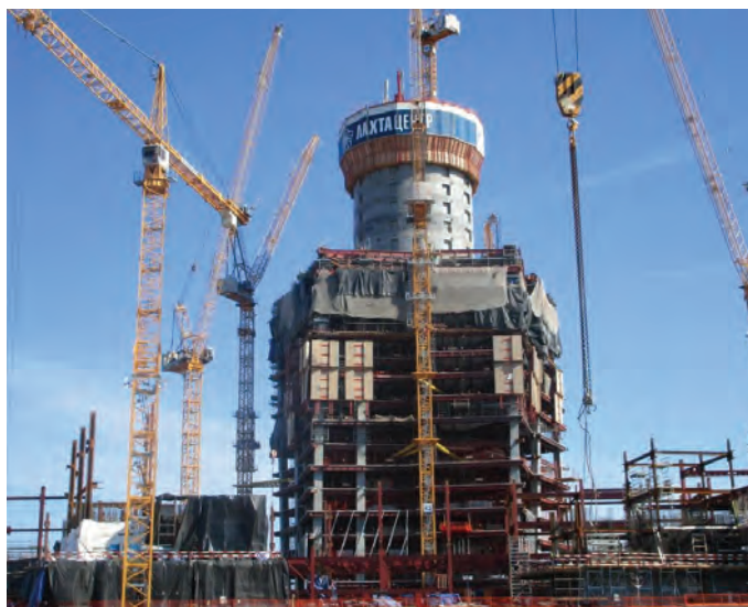
Slika 59 • Gradnja prvih etaž stolpnice.
