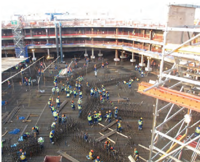
Slika 58 • Armiranje škatlastega temelja.
