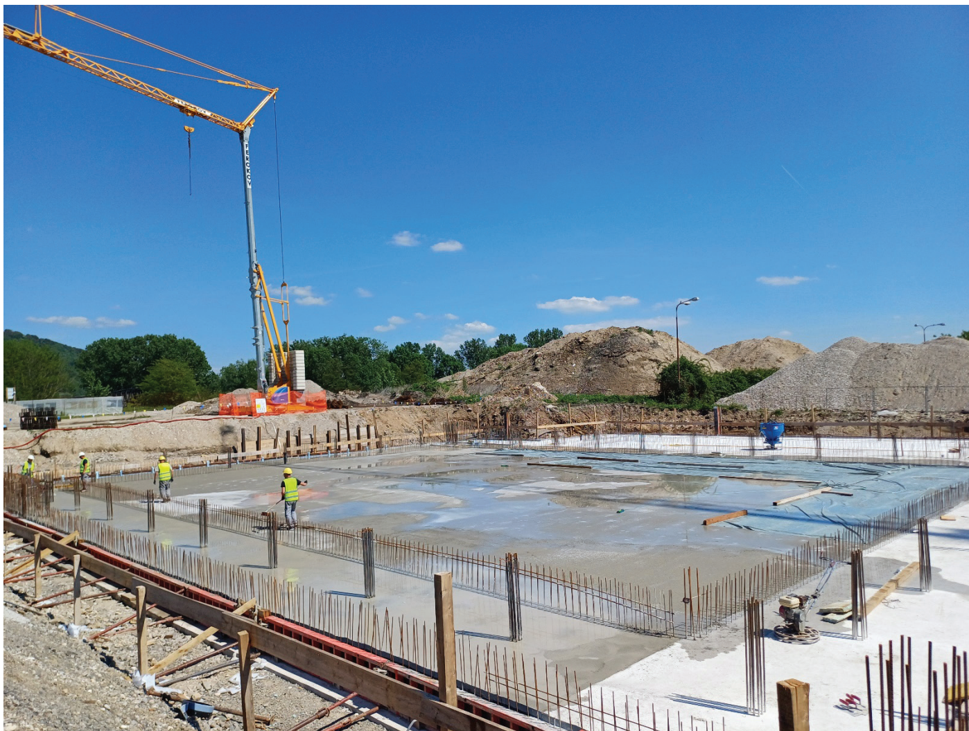
Slika 4. Nega betona.
