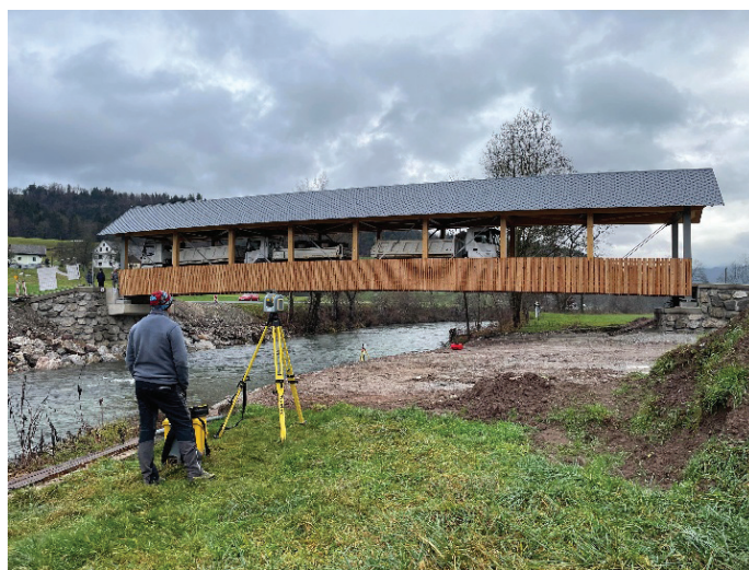
Slika 10. Obremenilni test, november 2024.
