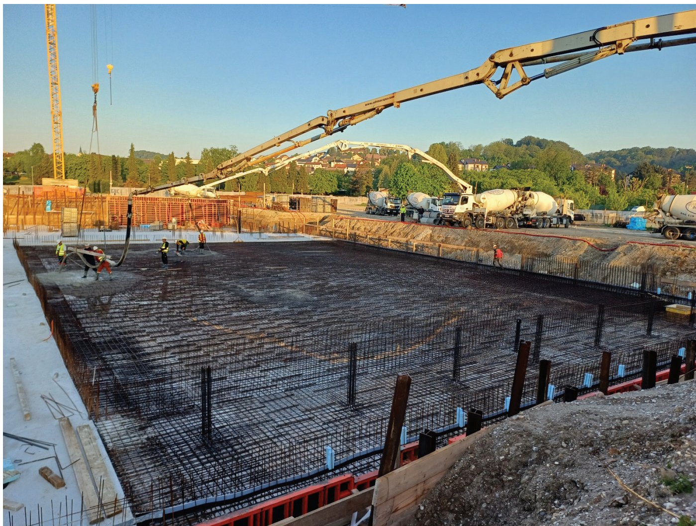
Slika 2. Jutranja betonaža.
