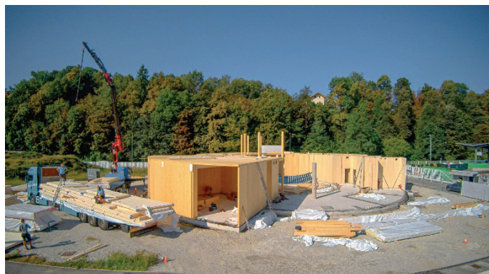
Slika 3. Gradnja pritlične etaže (19. 8. 2025). Foto: Nejc Vurnik.
