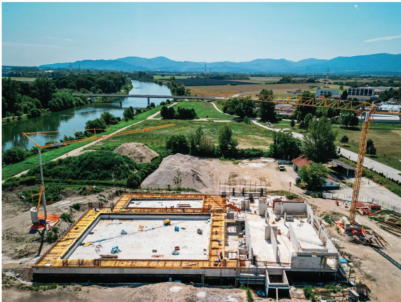
Slika 7. Gradbišče Bazena Krško – priprava za naslednjo fazo betoniranja.
