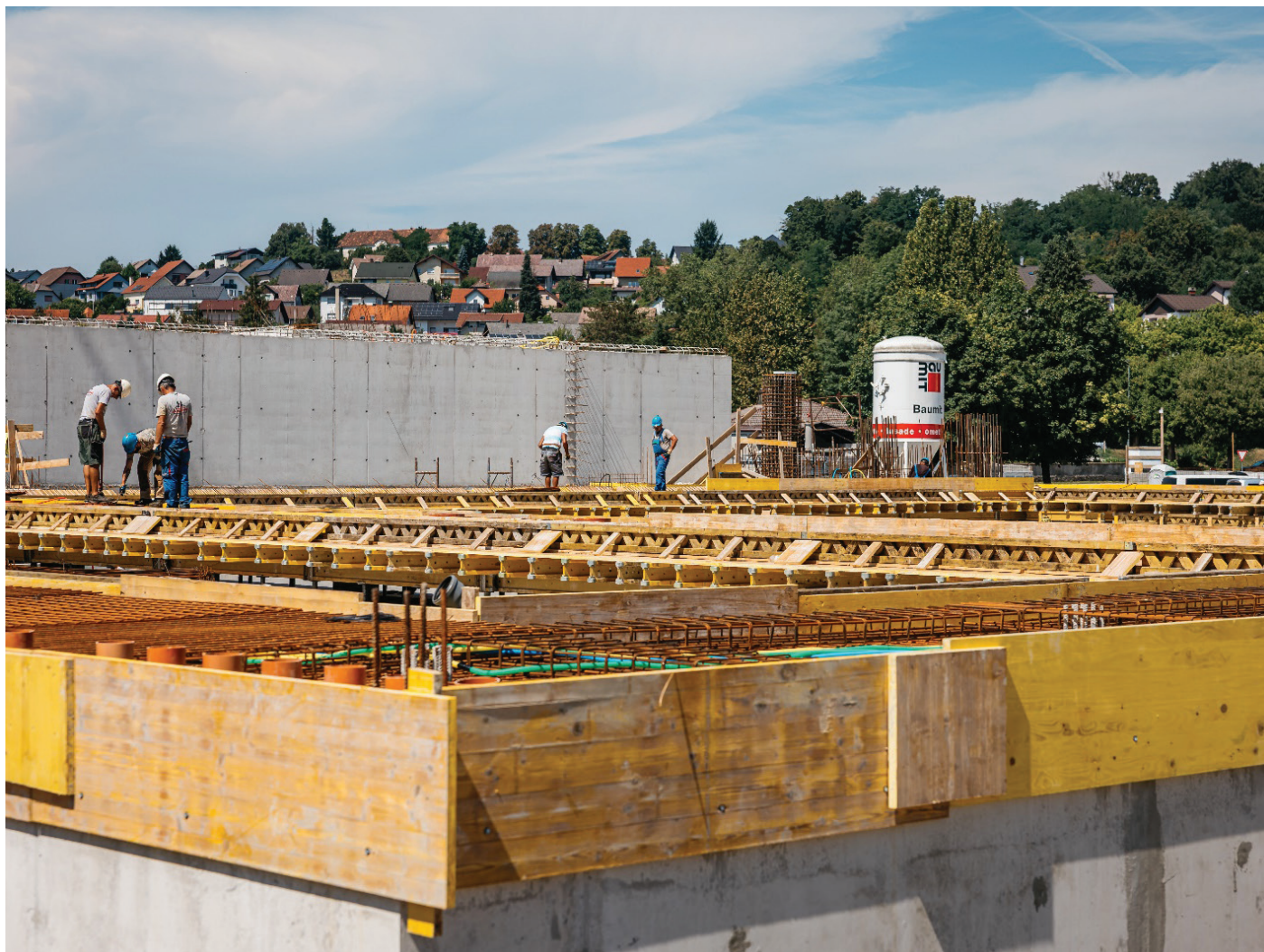
Slika 5. Dela na plošči nad kletjo.
