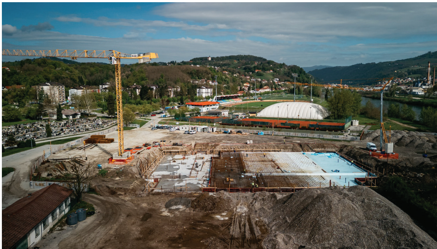
Slika 1. Gradbišče Bazen Krško.
