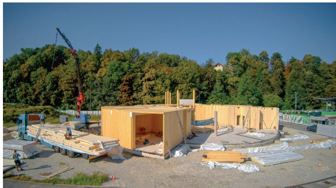
Slika 3. Gradnja pritlične etaže (19. 8. 2025). Foto: Nejc Vurnik.
