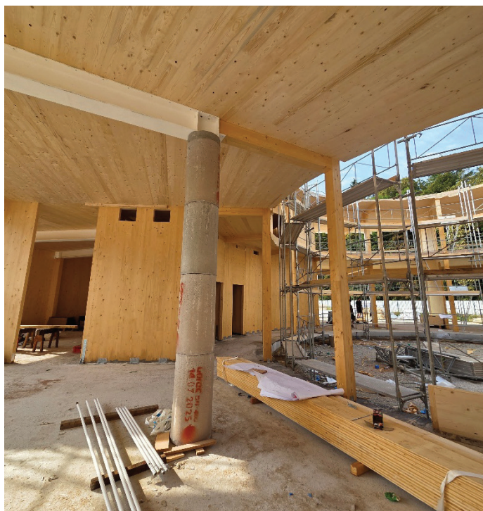
Slika 8. Kombinacija les-jeklo-beton. Foto: Katarina Sirk.
