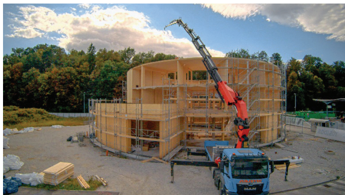
Slika 5. Zaključevanje zgornje, 2. etaže (1. 9. 2025). Foto: Nejc Vurnik.
