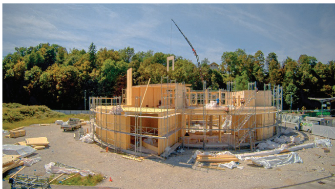
Slika 4. Izvedba 1. etaže (25. 8. 2025). Foto: Nejc Vurnik.
