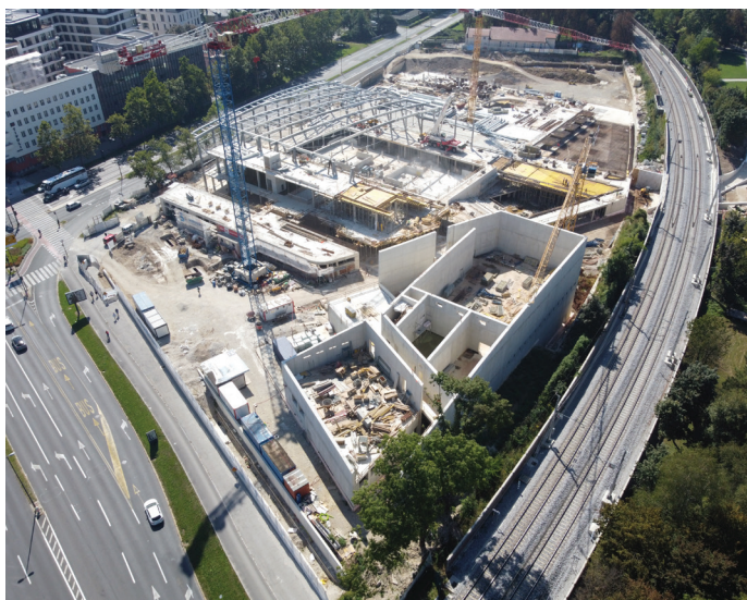
Slika 4. September 2023: Začnejo se dela na jekleni konstrukciji. Gradnja betonske konstrukcije za podzemno garažo in Lattermanov podhod je zaključena. (Foto: Aleš Dolenc, Elea iC, d. o. o.)
