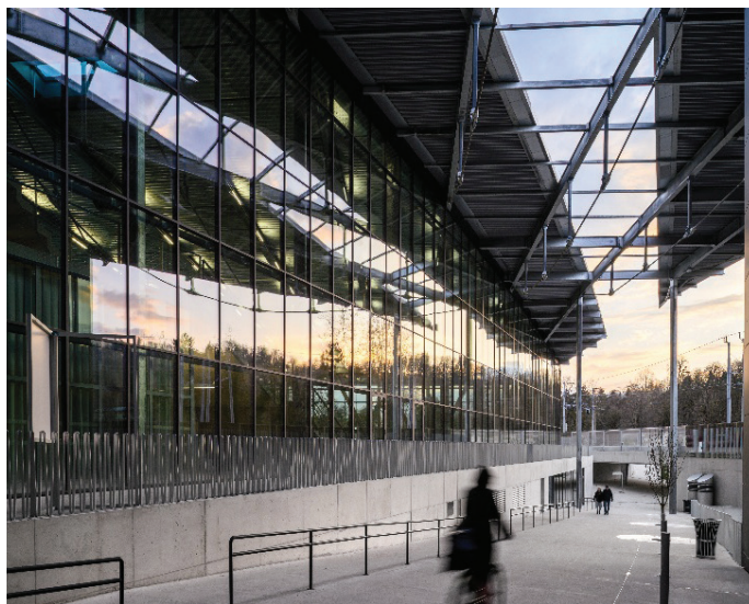
Slika 12. Dokončan objekt: Pogled na stekleno fasado in nov Lattermanov podhod, ki povezuje park Tivoli s centrom Ljubljane. Vsi jekleni elementi so na prehodih v notranjost objekta izvedeni z ustrezno prekinitvijo toplotnega mostu. (Foto: Miran Kambič)
