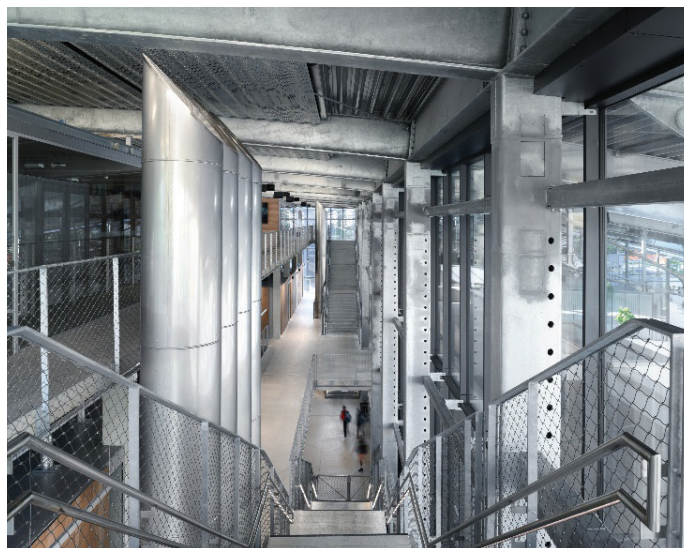
Slika 14. Notranjost glavne stavbe z bazenom. Zaradi estetskega videza so vsi spoji na jeklenih škatlastih profilih izvedeni znotraj profilov. Na podpornih stebrih so dodatno izdelane odprtine, ki omogočajo prezračevanje steklene fasade. (Foto: Miran Kambič)
