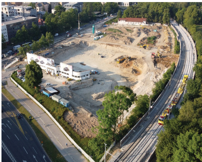
Slika 2. Junij 2022: Gradnja se začne z izkopom gradbene jame, pri čemer je ohranjen objekt kulturne dediščine, povezan z zgodovinskim bazenom Stanka Bloudka. (Foto: Aleš Dolenc, Elea iC, d. o. o.)
