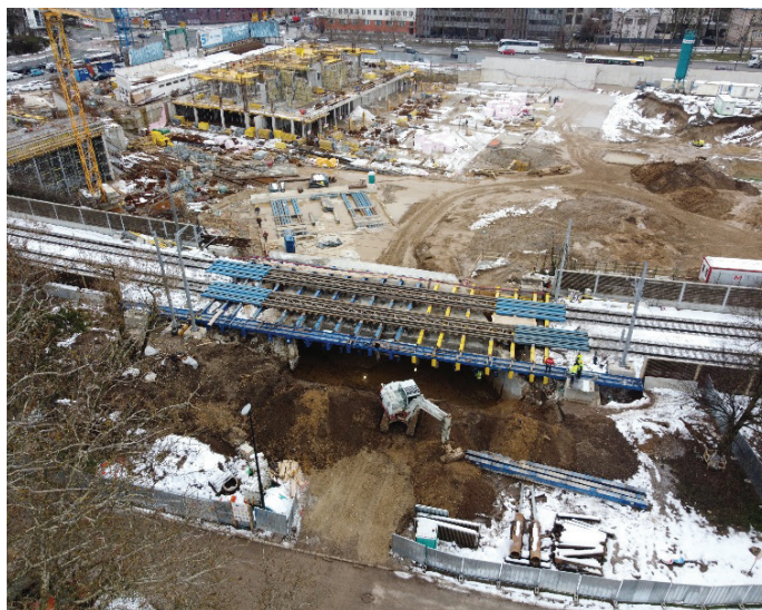
Slika 10. Lattermanov podhod: Podrivanje podhoda v končni položaj pod aktivnimi železniškimi tiri. To je najširši tovrstni objekt v Sloveniji, izveden s tehnologijo podrivanja. Objekt je bil na svoje mesto uspešno podrinjen februarja 2023. (Foto: Aleš Dolenc, Elea iC, d. o. o.)
