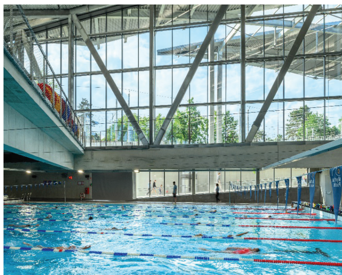
Slika 16. Vadbeni bazen s pogledom na Lattermanovo pasajo. Zaradi velikih razponov je za podporo armiranobetonskega nosilca in strehe stavbe uporabljeno močno jekleno paličje. Uporabljeno je bilo tudi naknadno napenjanje nosilcev z velikimi razponi. (Foto: Miran Kambič)
