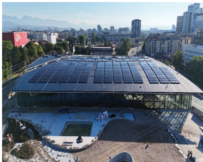
Slika 7. Trajnostni energetski koncept: Projekt vključuje strešno sončno elektrarno, ki letno proizvede približno 763,13 MWh, in sistem toplotnih črpalk voda-voda za ogrevanje stavbe in sanitarne vode ter hlajenje prostorov. (Foto: Aleš Dolenc, Elea iC, d. o. o.)
