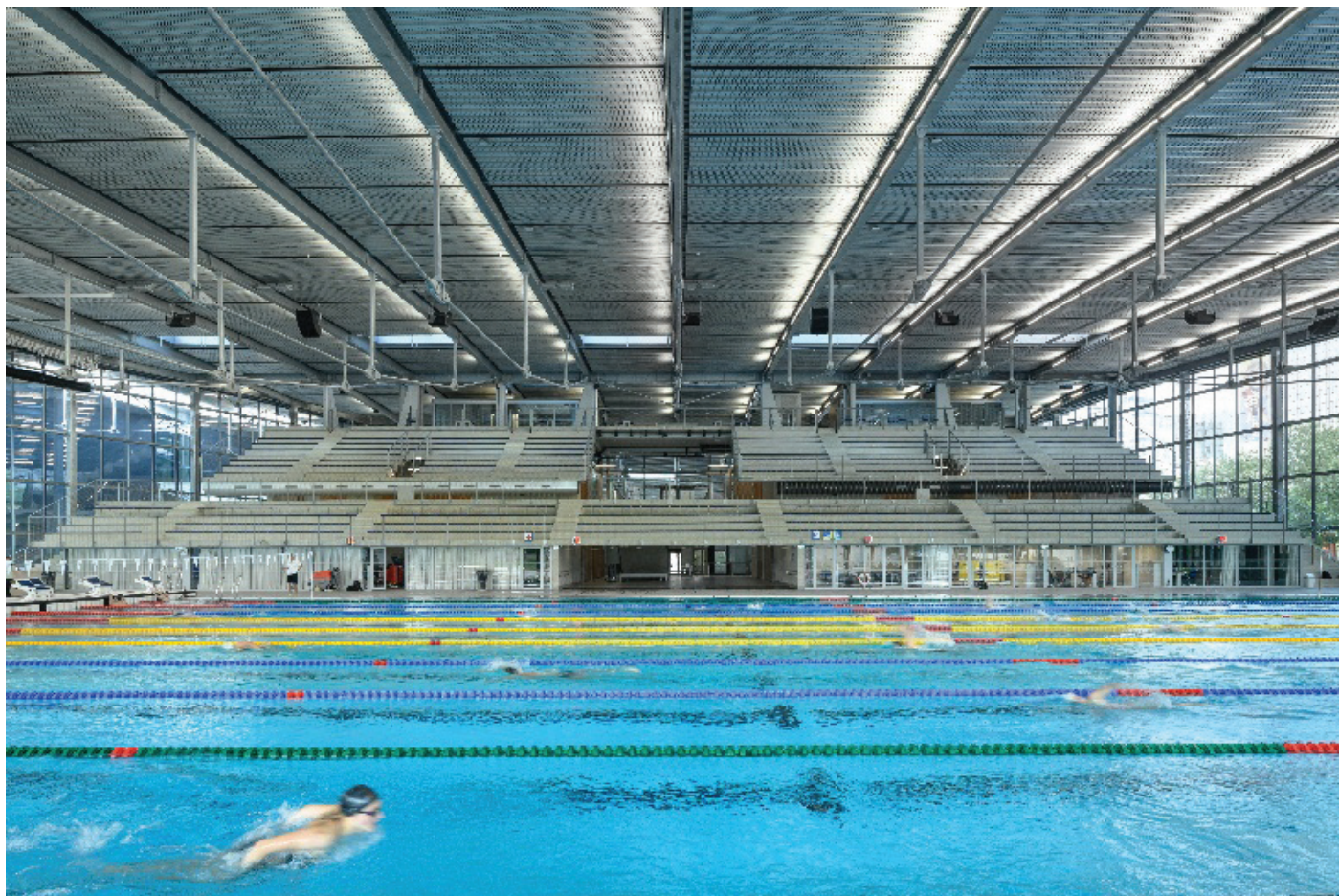
Slika 17. Olimpijski bazen s pogledom na tribuno s 1500 sedeži. Zaradi velikih razponov strehe, ki presegajo 50 metrov, so nekateri jekleni natezni elementi močno obremenjeni, tudi do 300 ton. (Foto: Miran Kambič)
