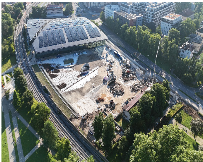
Slika 6. Julij 2024: Streha je dokončana, vključno s strešnimi okni in sončnimi kolektorji. Zaključuje se urejanje krajine na vrhu podzemne garaže. Enotna konveksna streha, ki se razteza čez tri stavbe, ustvarja neprekinjeno povezavo med vstopno ploščadjo in ljubljanskim parkom Tivoli. (Foto: Aleš Dolenc, Elea iC, d. o. o.)
