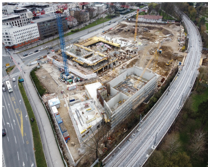
Slika 3. Marec 2023: Postavlja se betonska konstrukcija, hkrati pa se na zgodovinski stavbi izvaja strukturna ojačitev. Gradnja Lattermanovega podhoda poteka pod delujočim železniškim prometom. (Foto: Aleš Dolenc, Elea iC, d. o. o.)
