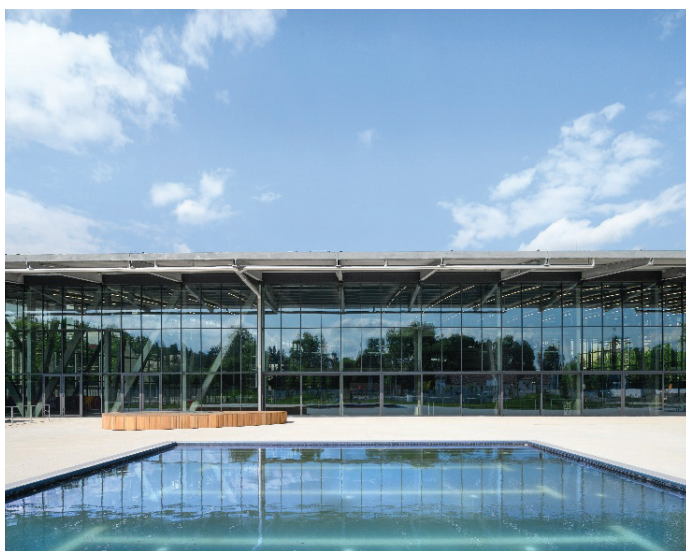
Slika 15. Glavna stavba, gledano iz južne strani, z zunanjim bazenom in stekleno fasado, ki omogoča pogled v glavno dvorano. Konzolni del strehe meri ca. 7 metrov. (Foto: Miran Kambič)
