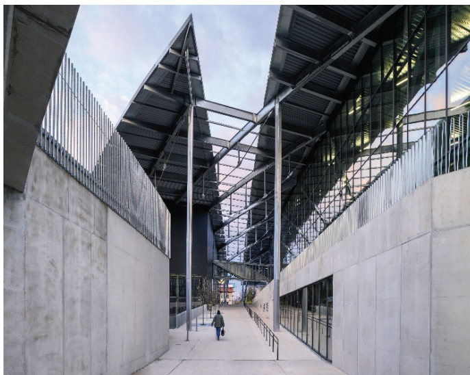
Slika 13. Pogled proti središču mesta (v ozadju Lattermanov podhod). Razdeljena streha ločuje telovadne dvorane (leva stavba) od plavalne dvorane (desna stavba). Celotna betonska fasada je izvedena iz montažnih betonskih elementov, vijakačenih na podkonstrukcijo iz jekla. (Foto: Miran Kambič)
