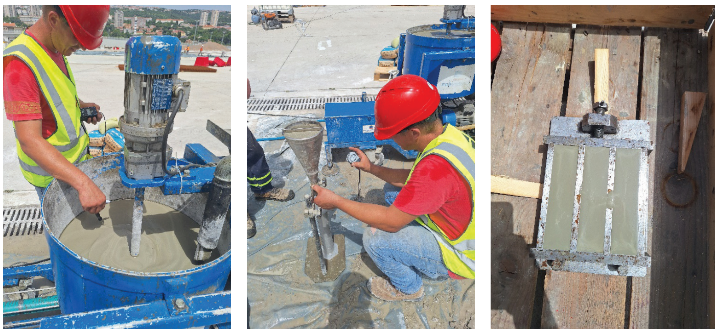
Slika 6. Priprava na injektiranje sider v izvrtinah, notranja kontrola injekcijske mase, odvzem vzorcev.
