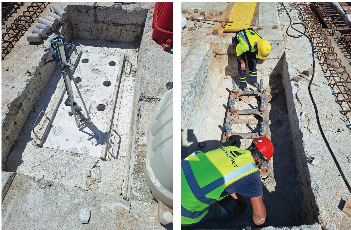
Slika 5. Kronsko vrtanje lukenj za sidra (levo), nameščanje sider in nastavljanje višin s pomočjo šablon in geodeta (desno) na privezu tipa WS – »water side« (tir ob robu pomola).
