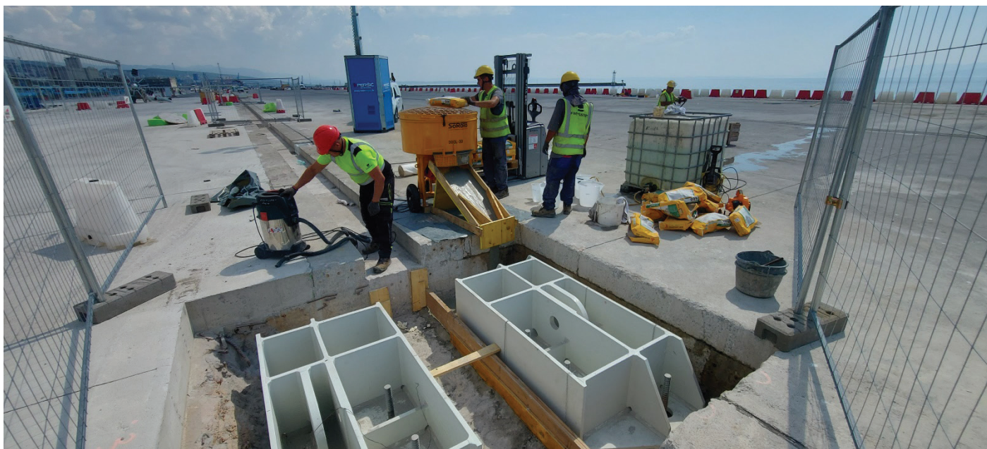
Slika 8. Podlivanje jeklenih elementov s podlivno malto sikagrout-800.
