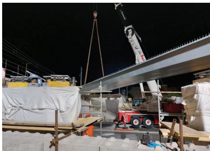
Slika 3. Začetni dvig jeklenega nosilca.
