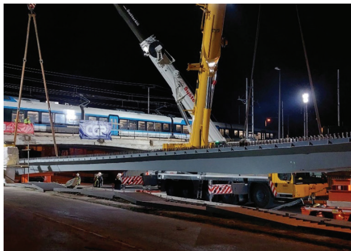
Slika 3. Začetni dvig jeklenega nosilca.
