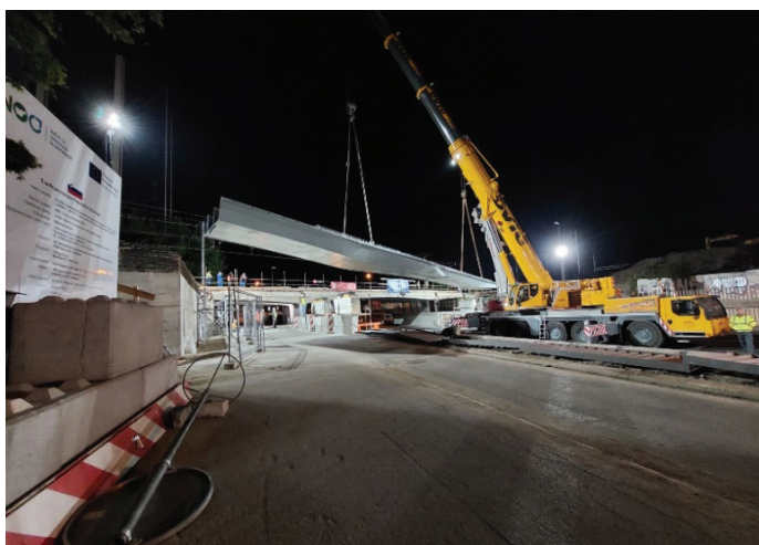
Sliki 4 in 5. Druga faza montaže – rotacija jeklenega nosilca.
