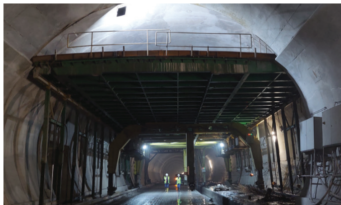
Slika 5. Opaž vmesne plošče.
