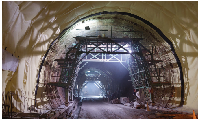
Slika 3. Hidroizolacija predora in izvedba armature notranje obloge.
