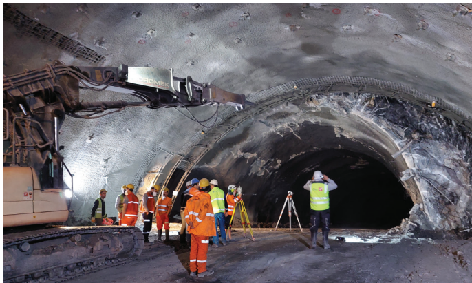
Slika 2. Izvedba prehoda iz območja razširjenega profila na območju odstavnice v dvopasovni predor.
