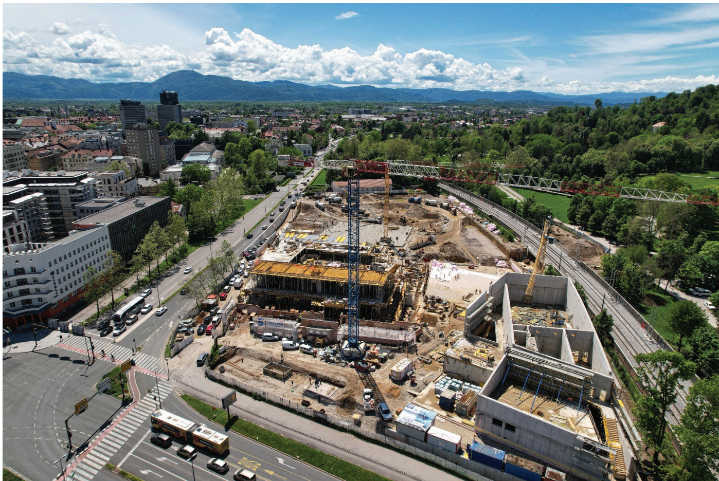
Slika 1. Pogled na gradbišče gradnje športnega centra Ilirija z vzhodne strani, maj 2023.
