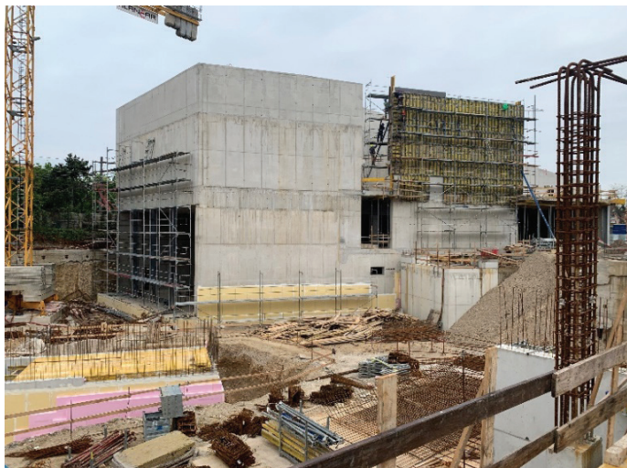
Slika 10. Izgradnja objekta C, ki bo namenjen športnim dvoranam, maj 2023.
