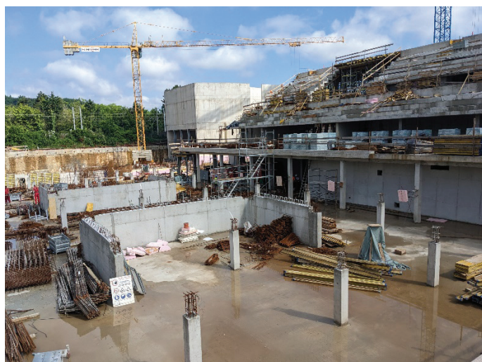
Slika 9. Ležišča plošče olimpijskega bazena, zadaj vidne tribune, ki bodo sprejele okrog 1000 gledalcev, julij 2023.
