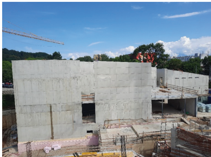
Slika 11. Dokončani vidni betoni objekta C, julij 2023.
