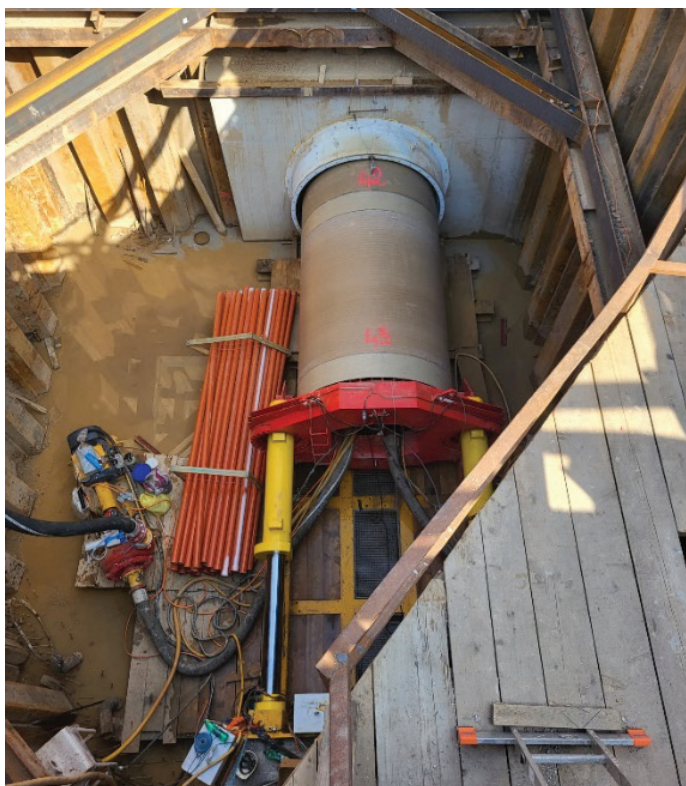
Slika 10. Potiskanje cevi med izvedbo mikrotunela.
