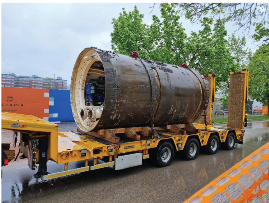
Slika 14. Transport vrtalne glave na vstopno gradbeno jamo.
