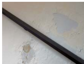
Slika 2 • Vlaga v zidovih in odpadanje ometa (levo in sredina) ter poškodbe na ometu zgradbe (desno)
