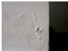
Slika 2 • Vlaga v zidovih in odpadanje ometa (levo in sredina) ter poškodbe na ometu zgradbe (desno)
