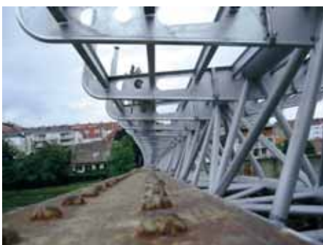
Slika 13 • Montaža sekundarne konstrukcije (junij – avgust 2007)
