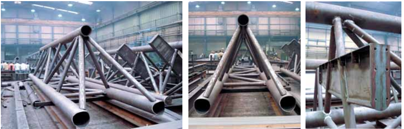
Slika 11 • Izdelava nosilne konstrukcije v delavnici (februar – maj 2007)
