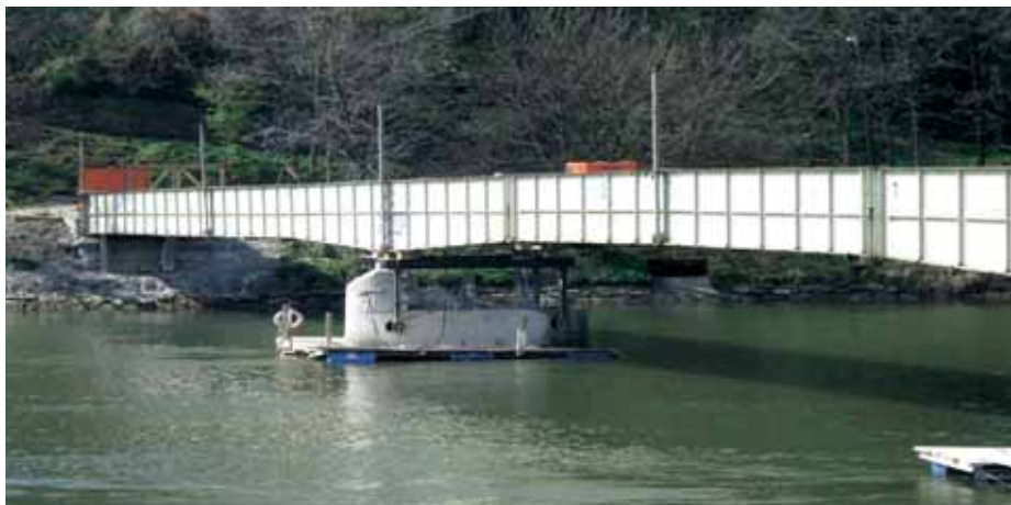
Slika 10 • Sanacija vmesnih podpor v rečni strugi (marec 2007)
