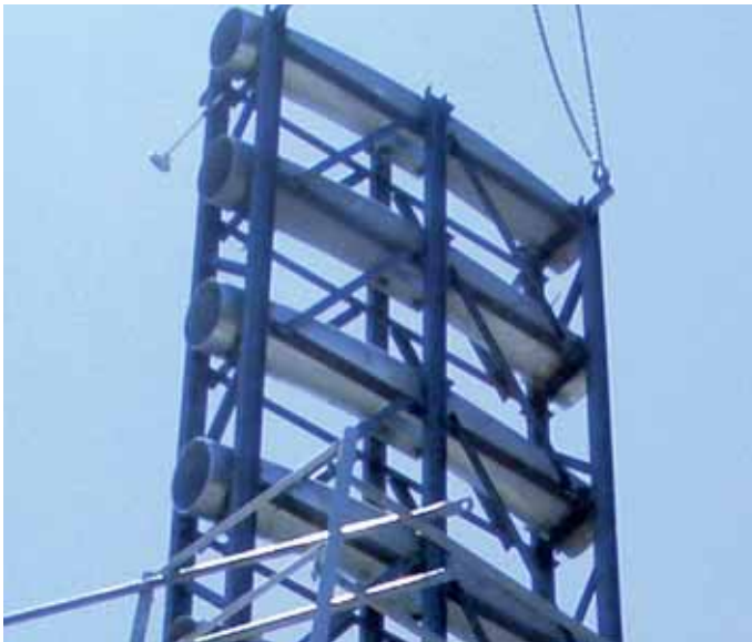
Slika 9 • Kletka s privarjenimi deviatorji pred vstavitvijo v opaž pilona
