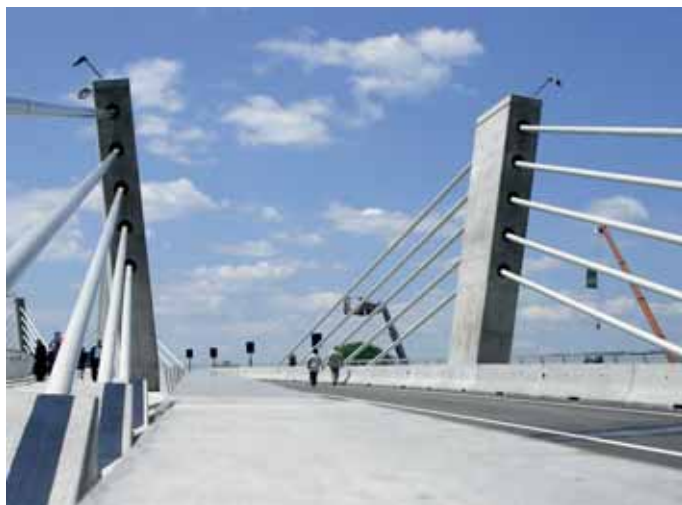
Slika 3 • Fotografija nedokončanega vozišča mosta
