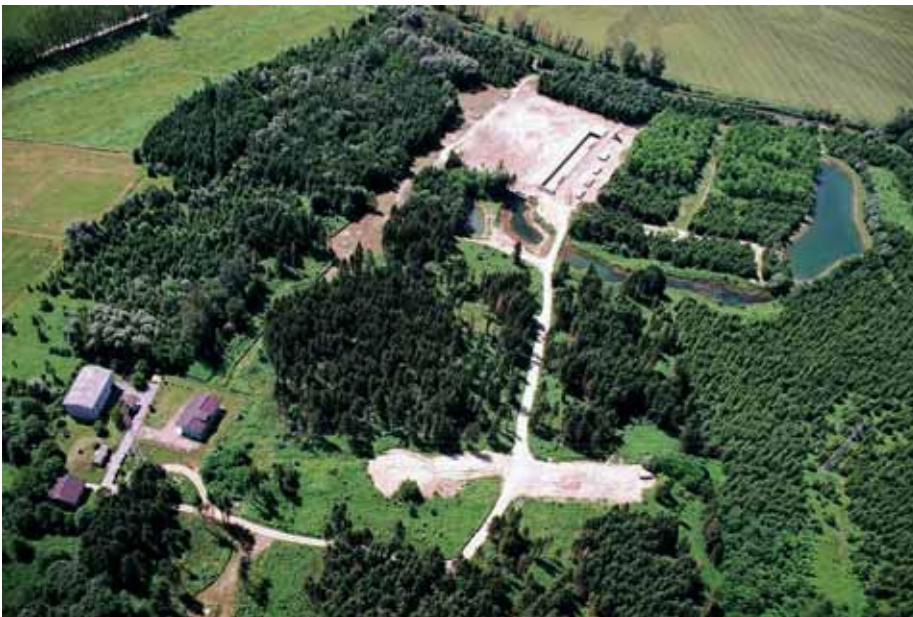
Slika 13 • Leta 2006 dograjeno prvo ponikalno polje s 5 novimi vodnjaki levo od ponikalnega polja, kot je prikazano na sliki 3. Na levi strani spodaj vodni rezervoar, levo obstoječa čistilna naprava, spodaj glavno črpališče
