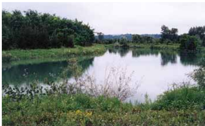
Slika 5 • Zemeljski bazen za varnostno zalogo vode se uporablja v prvi fazi izgradnje kot usedalnik in infiltracijski bazen za bogatenje podtalnice
