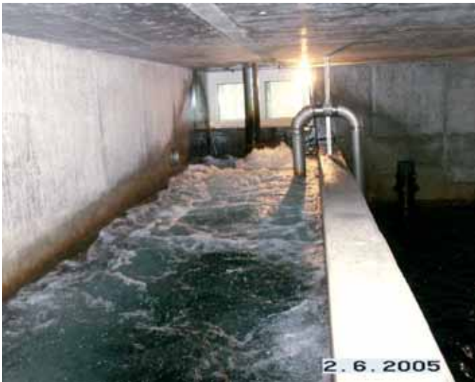
Slika 6 • S pomočjo ejektorja se črpna voda v manjšem bazenu izravnalnega rezervoarja zasiti s kisikom
