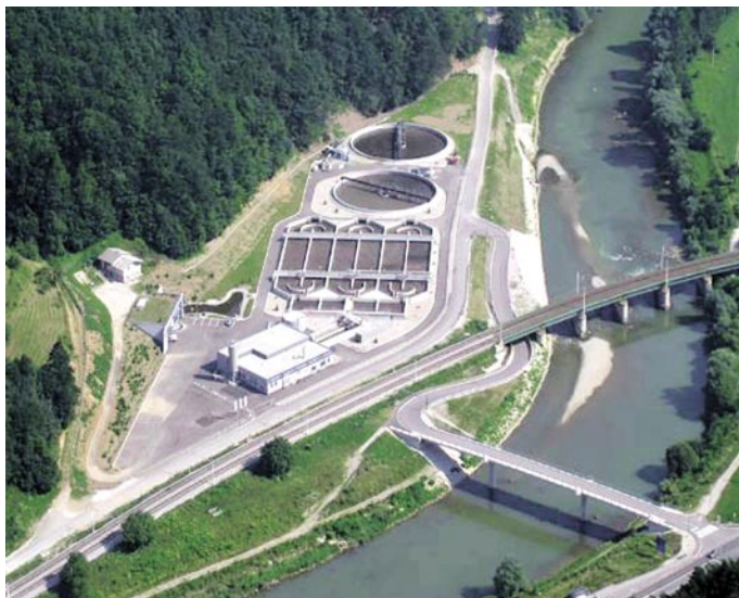
Slika 6 • Celjska čistilna naprava 90.000 PE, III. stopnja čiščenja, primer racionalne rabe prostora
