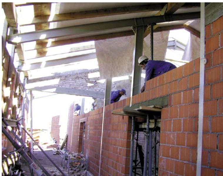
Slika 10 • Nadgradnja mansarde šole
