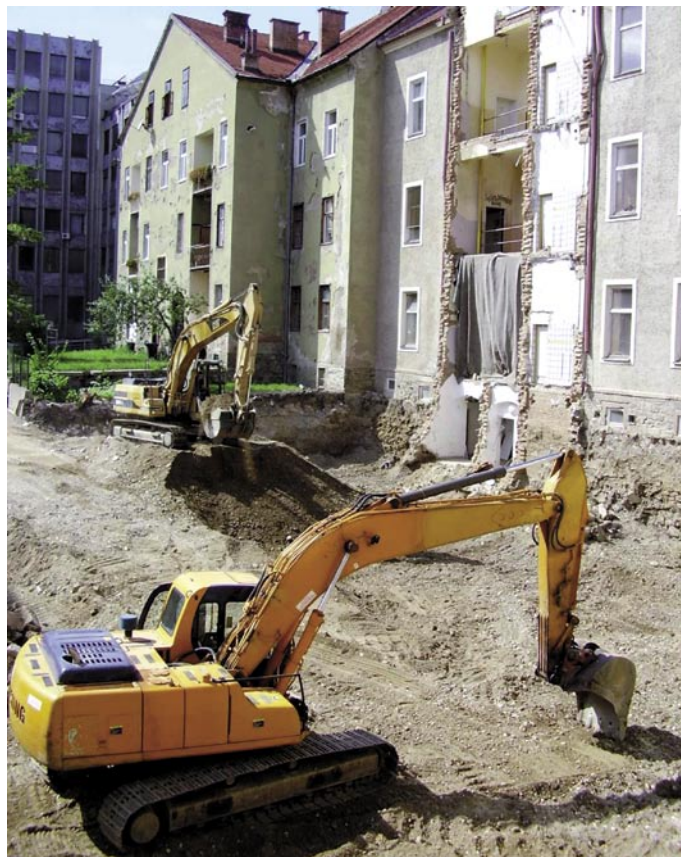
Slika 6 • Izkop gradbene jame
