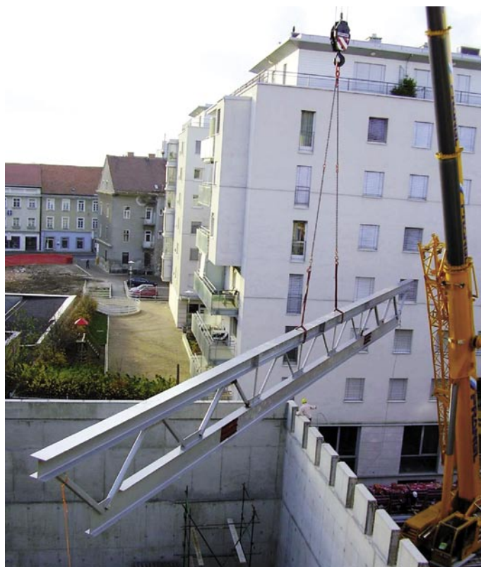
Slika 9 • Montaža jeklenih paličnih nosilcev strehe telovadnice
