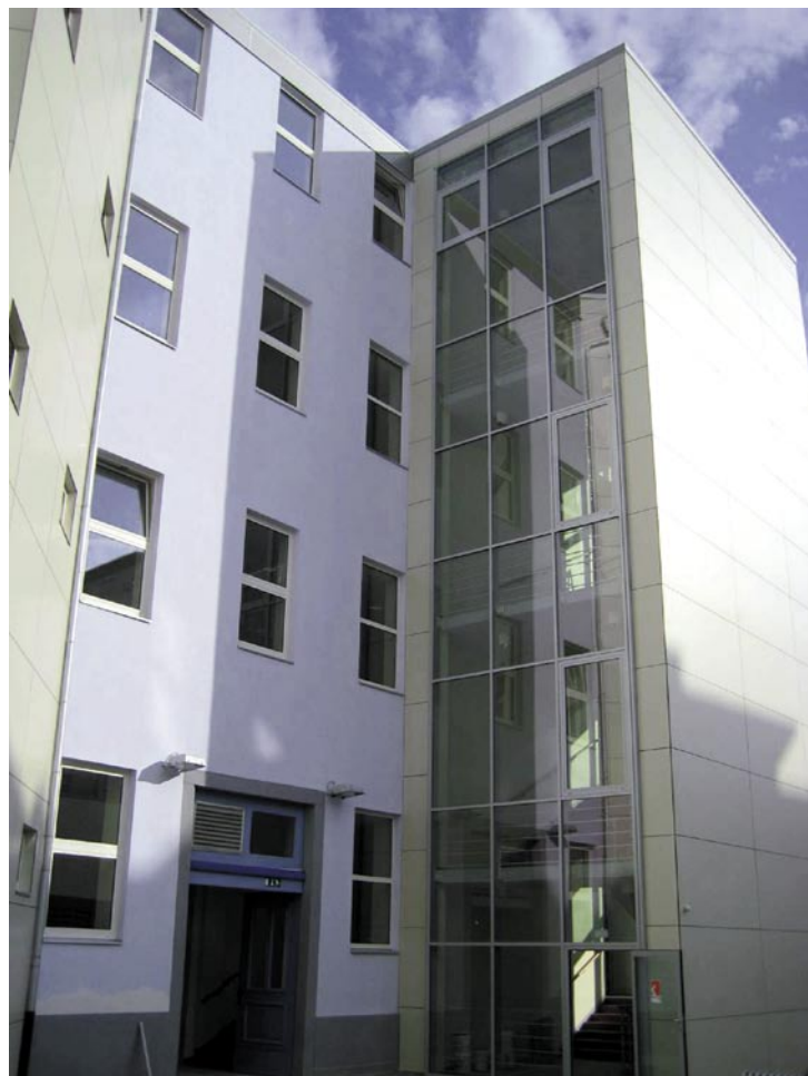
Slika 13 • Novo betonsko stopnišče
