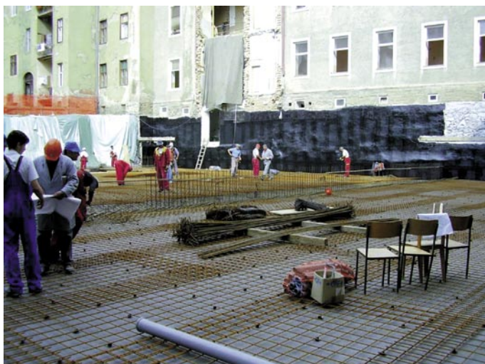
Slika 7 • Armiranje temeljne plošče telovadnice in spremljajočih prostorov
