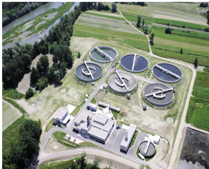
Slika 7 • Mariborska čistilna naprava 230.000 PE, III. stopnja čiščenja, primer racionalne rabe prostora
