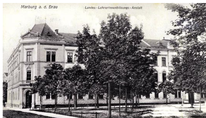
Slika 2 • Fotografija poslopja šole s prvotno fasado, posneta okoli leta 1906 (PAM, 1906)
