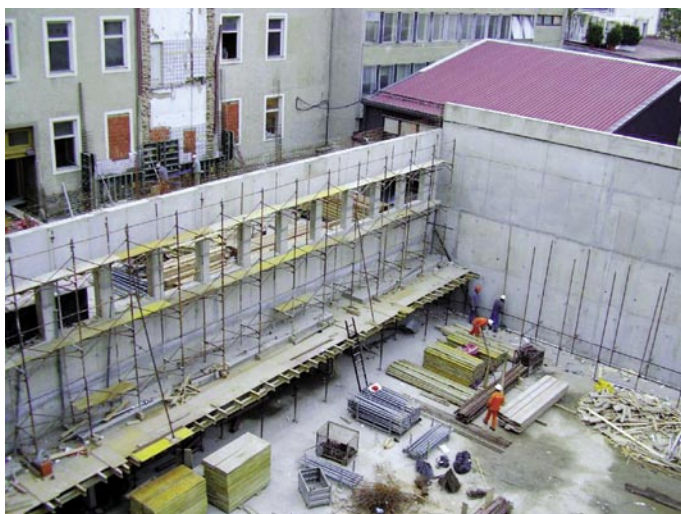
Slika 8 • Betonske stene nove telovadnice
