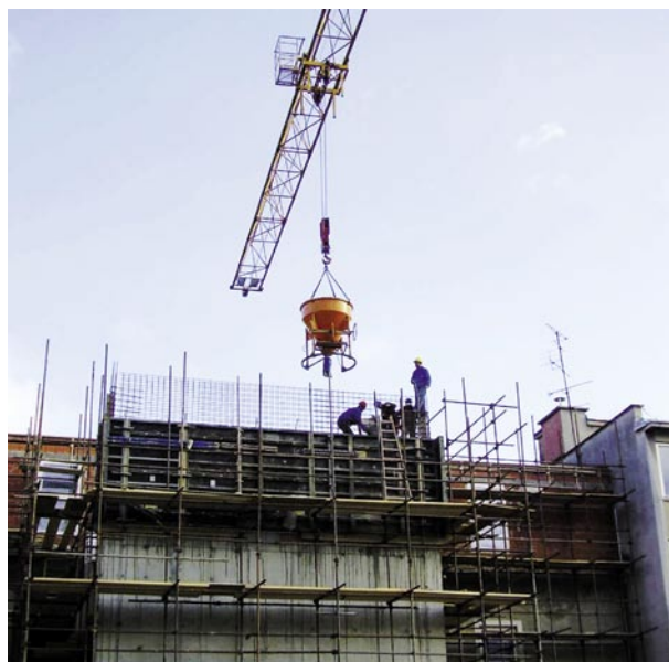
Slika 11 • Betoniranje sten novega stopnišča
