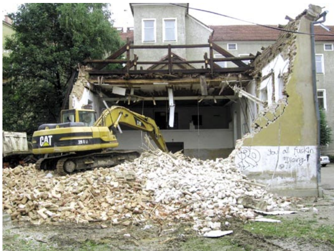
Slika 5 • Rušitev stare telovadnice
