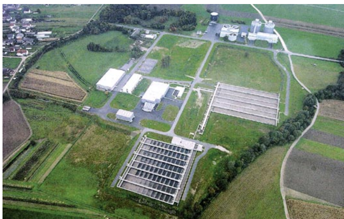
Slika 8 • Tehnično-ekonomsko nefunkcionalna in prostorsko potratna gradnja ljubljanske čistilne naprave 360.000 PE brez III. stopnje čiščenja
